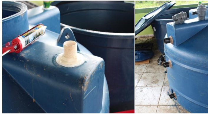
Figura 8. Instalación del Biodigestor Prototipo. Instalación del reactor (Elaboración Propia)
