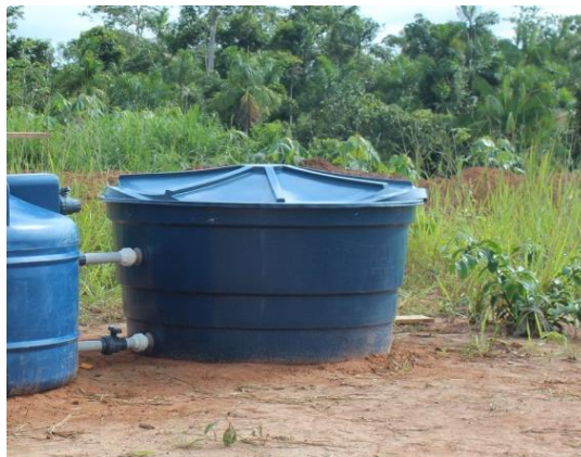
Figura 12. Tanque Almacenador de Efluentes Instalación de los tanques (Elaboración propia).
