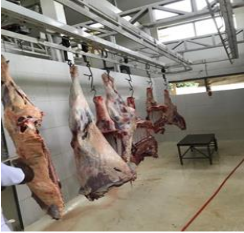
Fotografía 14 Zona de oreo y refrigeración
