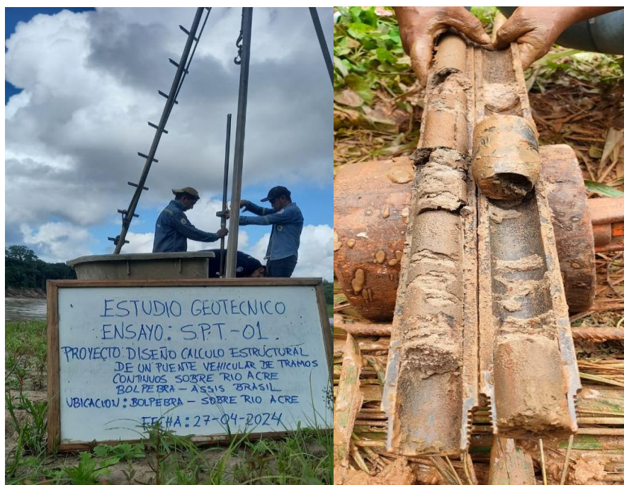
Figura 3.17 Ensayo de suelos in situ
