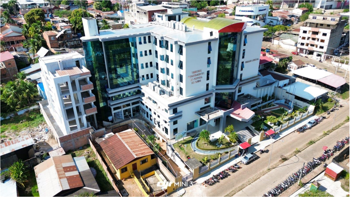
Figura 15. Obra de la constructora consultora G & G S.R. L Fuente: Elaboración propia.
