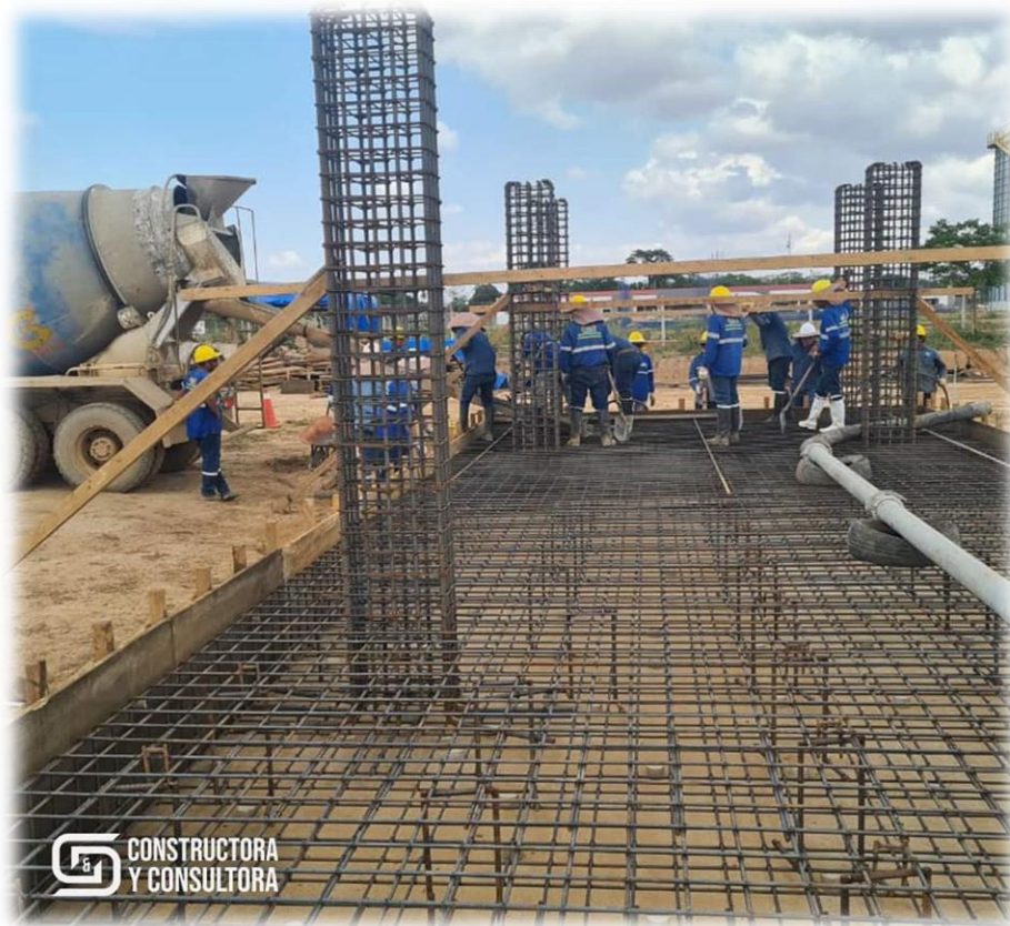
Figura 22. Personal técnico en obra. Fuente: Elaboración propia.
