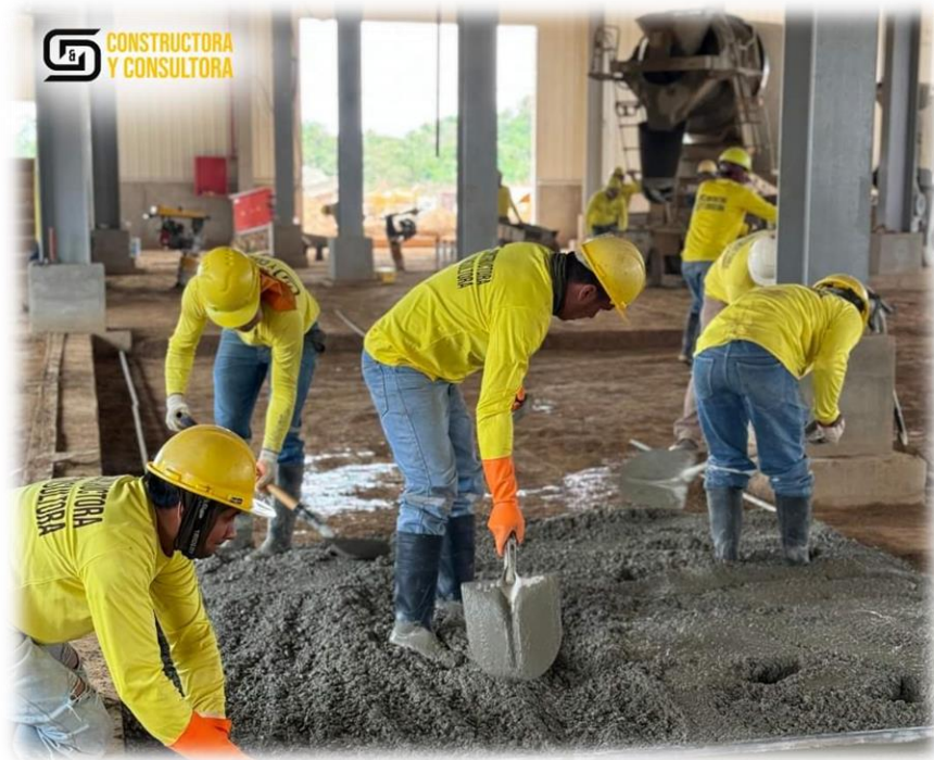
Figura 24. Personal técnico en obra. Fuente: Elaboración propia.
