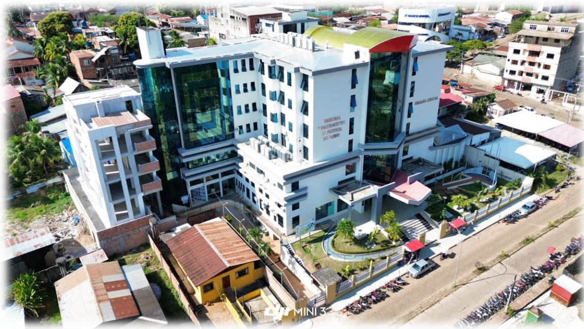
Figura 17. Obra de la constructora consultora G & G S.R. L palacio de justicia Fuente: Elaboración propia.
