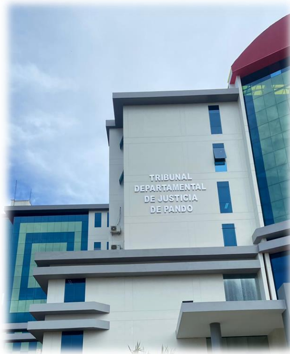
Figura 18. Obra de la constructora consultora G & G S.R. L Fuente: Elaboración propia.
