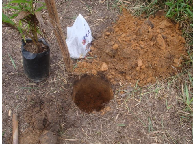
Fotografía N° 5.- Excavación de hoyos.
