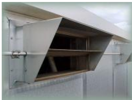
Figura 6.5: Ventilación o clapetas
