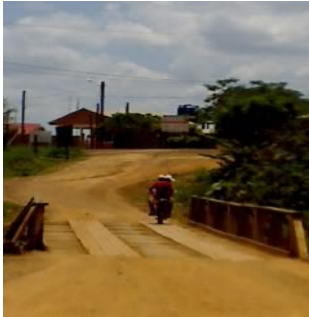
Puente del barrio Cataratas
