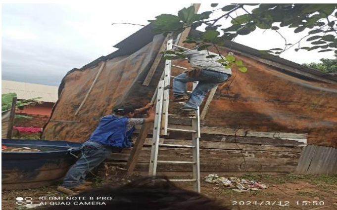
Figura 5. Instalación de servicios
