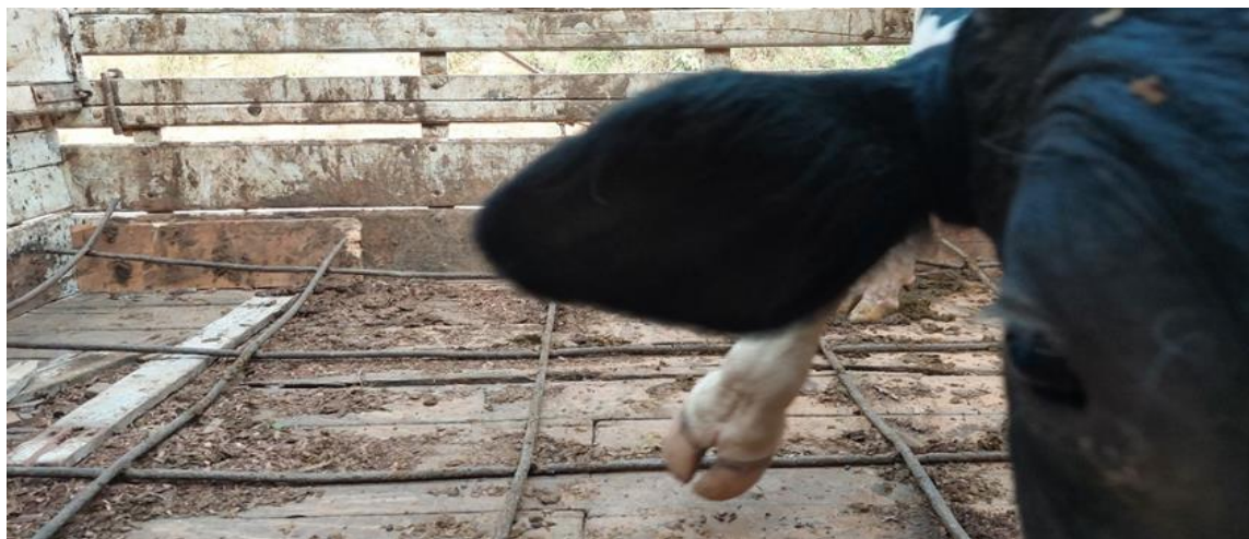
Figura 8 Piso con rejillas de metal sobresaliendo
