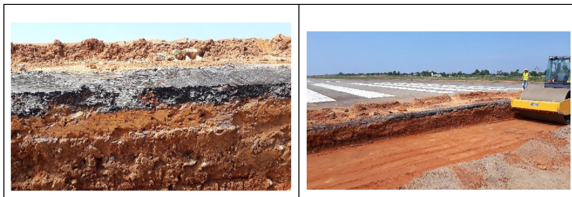
ILUSTRACIÓN 13. PAQUETE ESTRUCTURAL PISTA ANTIGUAPISTA ANTIGUA
