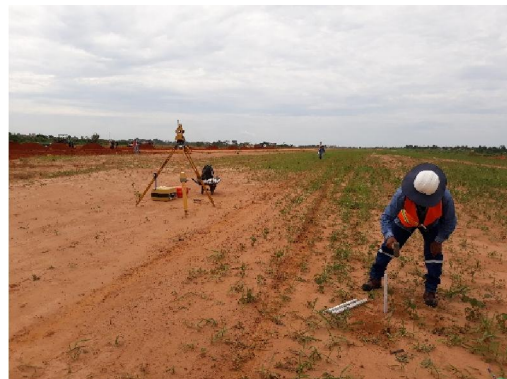
Brigada topográfica de la Supervisión en labor de replanteo y control geométrico de capas de erraplén, ampliación de pista 2+000 a 2+500. Fuente: Elaboración Propia
