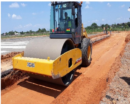
Franja nivelada y estabilización de franja.
