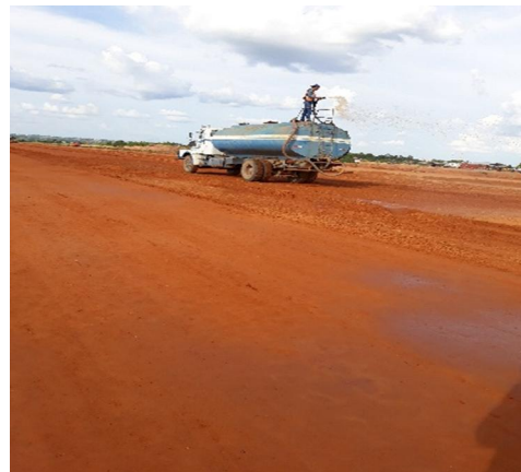
Franja nivelada y estabilización de franja.
