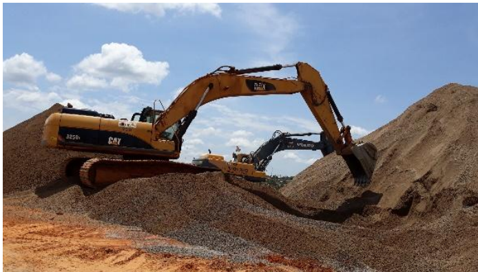
ILUSTRACIÓN 26. PRODUCCIÓN Y ACOPIO DE MATERIAL PARA CAPA BASE
