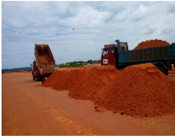
Ampliación de pista – tramo 2+000 a 2+600, conformación a nivel sub-rasante
