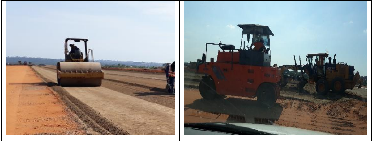
ILUSTRACIÓN 29. FASE FINAL DE LA CONFORMACION DE LA CAPA BASE A TRAVES DE LA COMPACTACION
