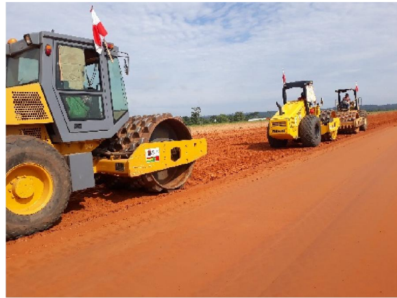
Ampliación de pista – tramo 2+000 a 2+600, conformación a nivel sub-rasante
