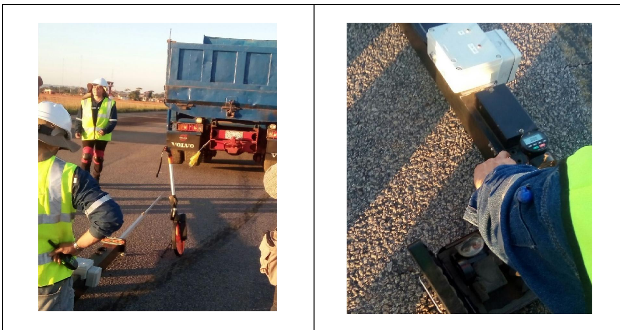
ILUSTRACIÓN 11. ENSAYO DE DEFLECTOMETRIA CON VIGA BENKELMAN EN LA ACTUAL PISTA DEL AEROPUERTO
