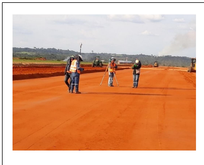
ILUSTRACIÓN 18. BRIGADA TOPOGRÁFICA DE LA SUPERVISIÓN EN LABOR DE REPLANTEO Y CONTROL GEOMÉTRICO DE CAPAS DE TERRAPLÉN, AMPLIACIÓN DE PISTA 2+000 A 2+500.
