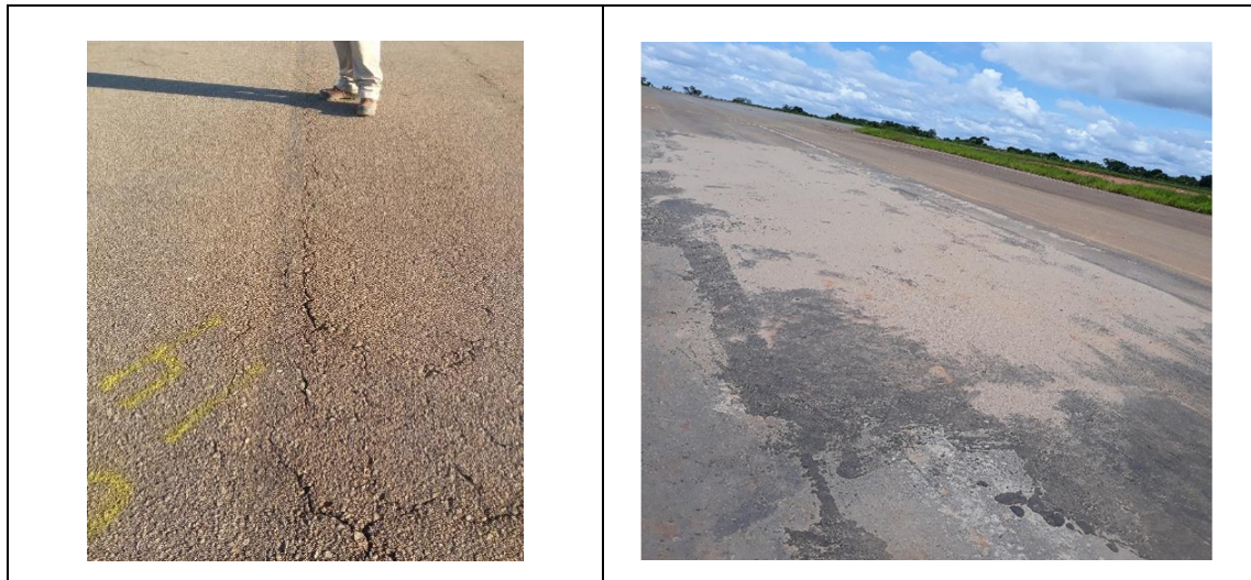
ILUSTRACIÓN 14. SELLADO DE FISURAS Y BACHEO SUPERFICIAL Y EXTENDIDO DE MATERIAL DE SECADO (ARENA) SOBRE LA SUPERFICIE ASFÁLTICA
