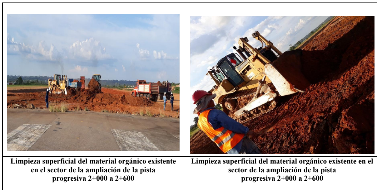
ILUSTRACIÓN 17. PREPARACIÓN DE LA CAPA SUB-RASANTE
