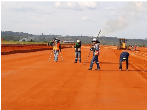
Brigada topográfica de la Supervisión en labor de replanteo y control geométrico de capas de erraplén, ampliación de pista 2+000 a 2+500. Fuente: Elaboración Propia
