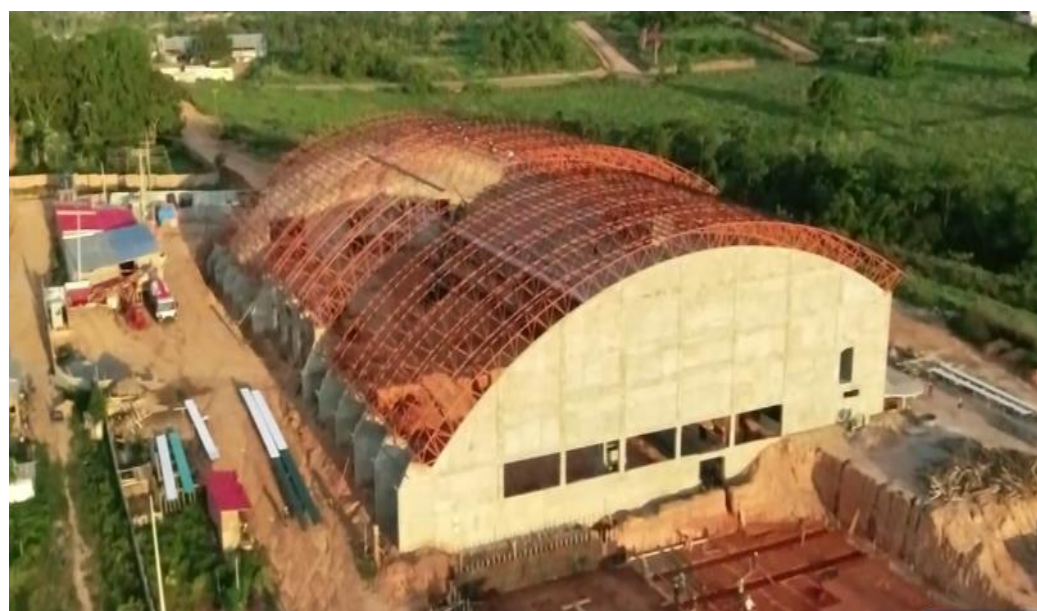
Imagen 4. 13. Montaje de cerchas Fuente: Elaboración propia.
