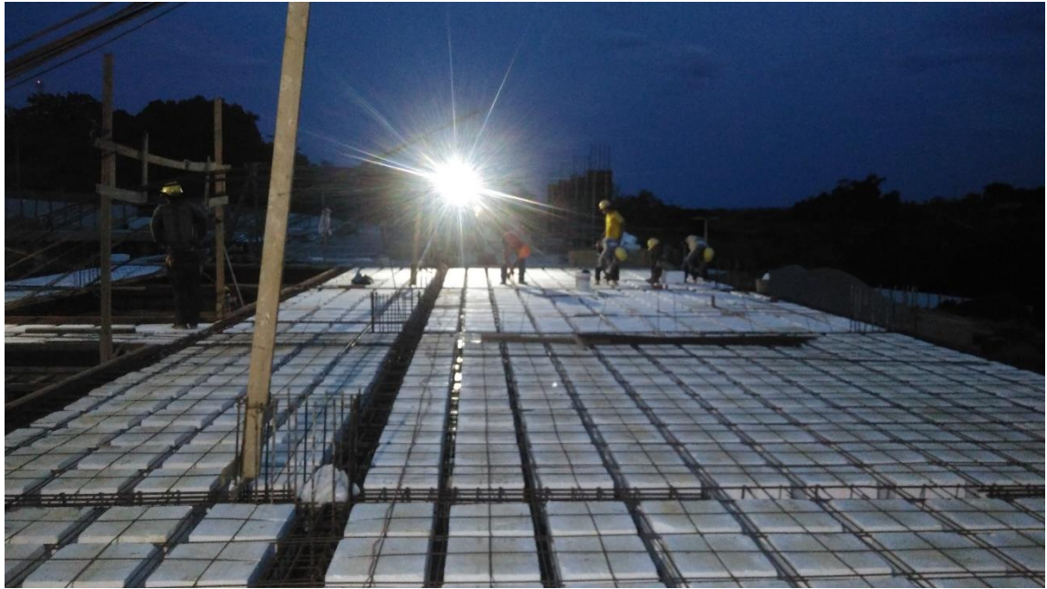
Imagen 4. 5. Armado de losa bidireccional casetonada.
