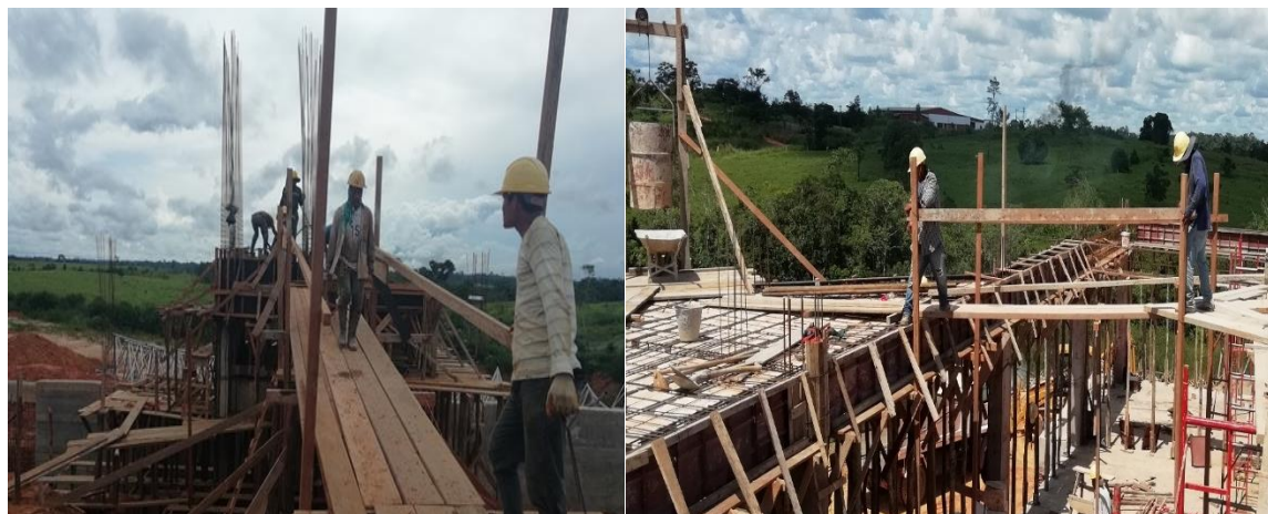
Imagen 4. 21. Trabajos en altura barandas provisionales.
