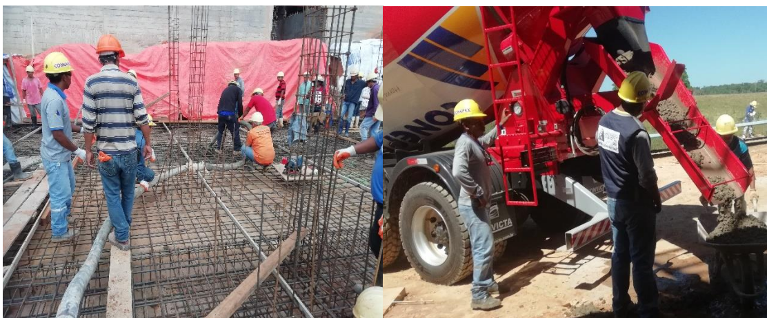
Imagen 4. 15. Uso de implementos de seguridad.
