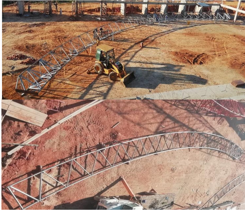
Figura 4. 17. Replanteo de cerchas.
