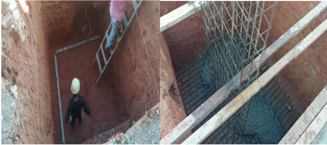
Imagen 4. 1. Zapatas de hormigón armado.
