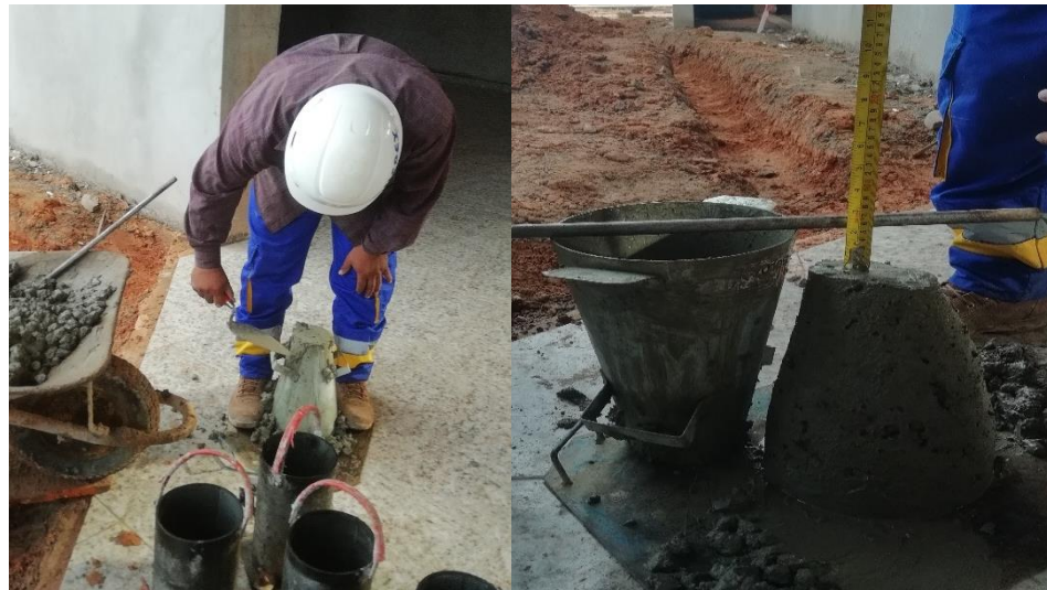
Imagen 4. 27. Medición de consistencia del hormigón.
