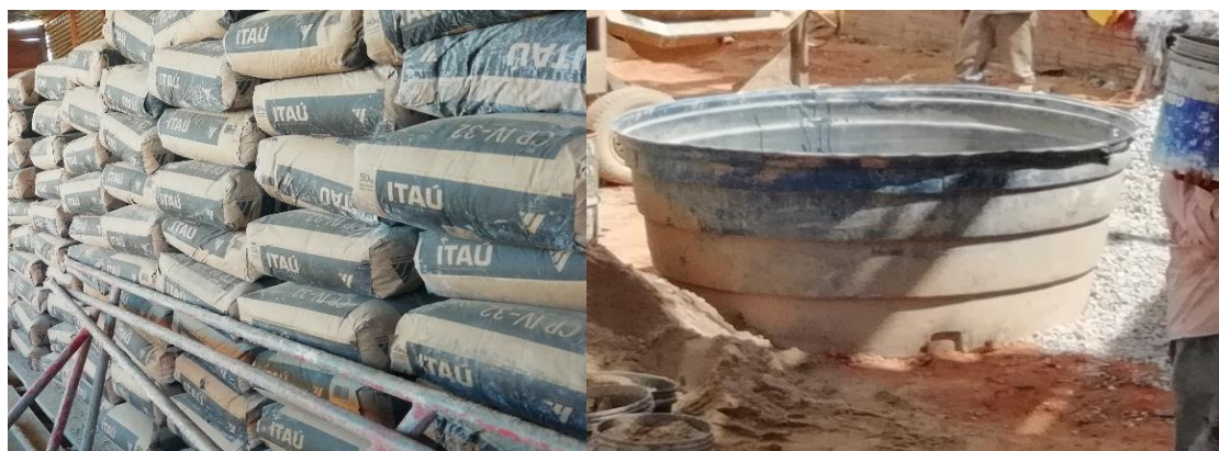
Imagen 4. 25. Acopio de cemento y agua.
