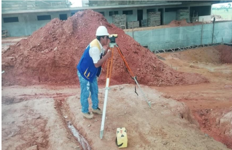
Imagen 4. 8. Nivelación de terreno.
