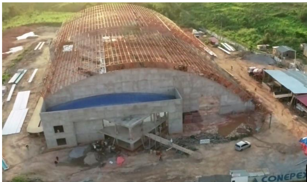
Imagen 4. 12. Montaje de cerchas Fuente: Elaboración propia.
