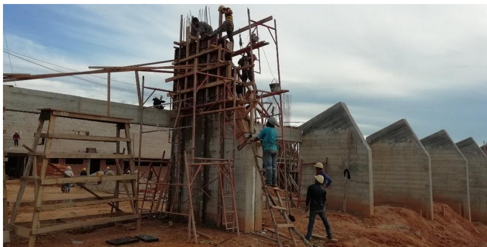
Imagen 4. 9. Vaciado de soportes estructura metálica.
