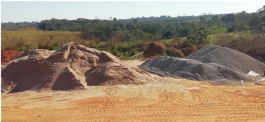
Imagen 4. 24. Acopio de materiales arena y brita.
