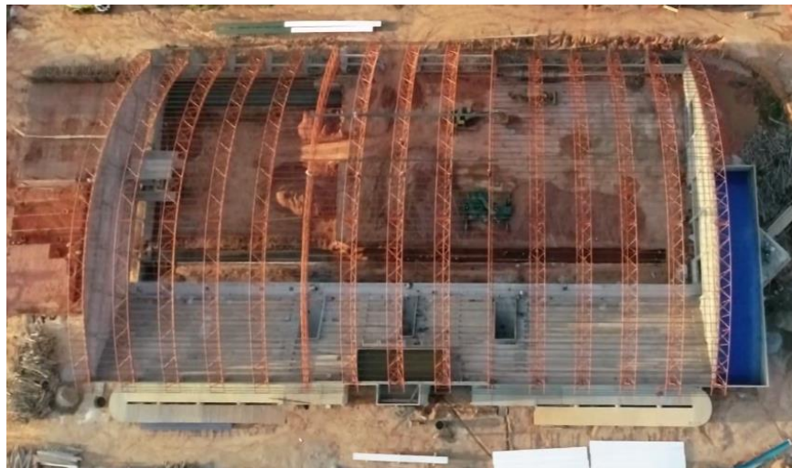
Imagen 4. 11. Vista planta colocado de soporte estructura metálica
