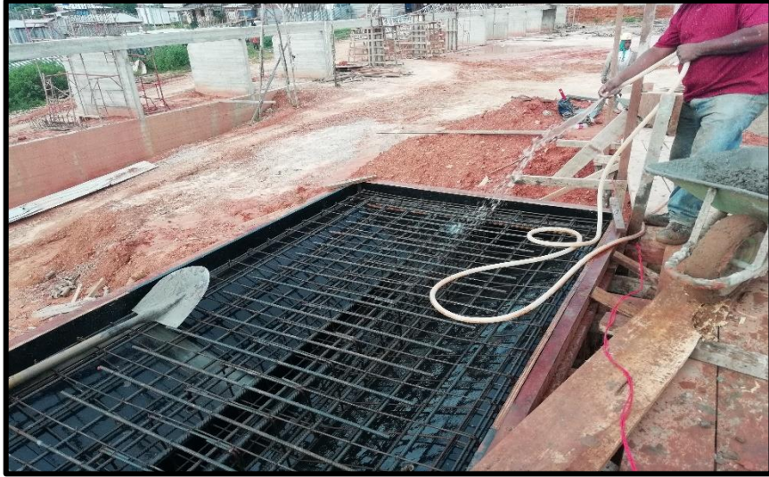
Imagen 4. 6. Armado de plataformas de saltos.
