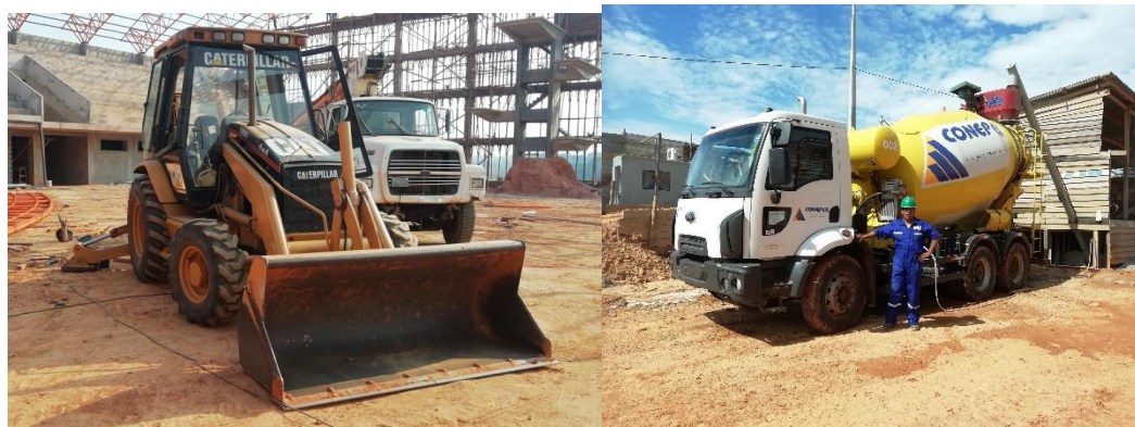
Imagen 4. 17. Equipo y maquinaria.
