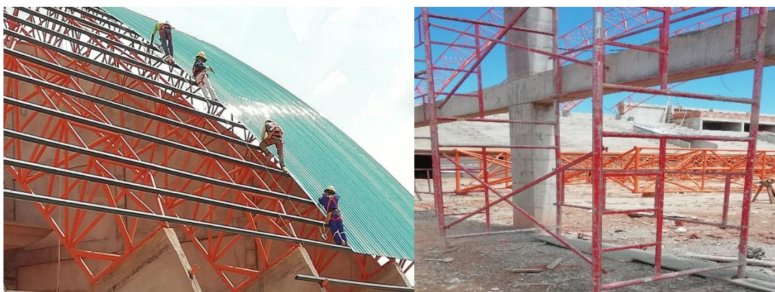
Imagen 4. 20. Trabajo en alturas.
