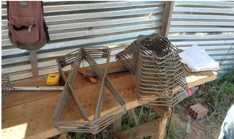
Imagen 4. 2. Preparado de armadura.
