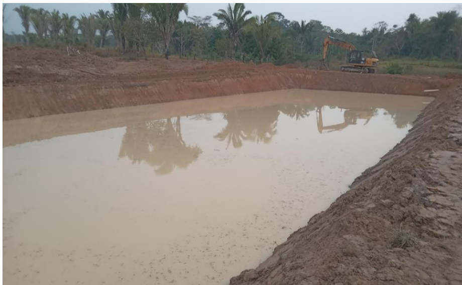
Foto 14. Construcción de piscinas para piscicultura
