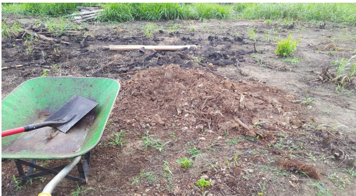
FOTO N. ° 2 Preparación del sustrato
