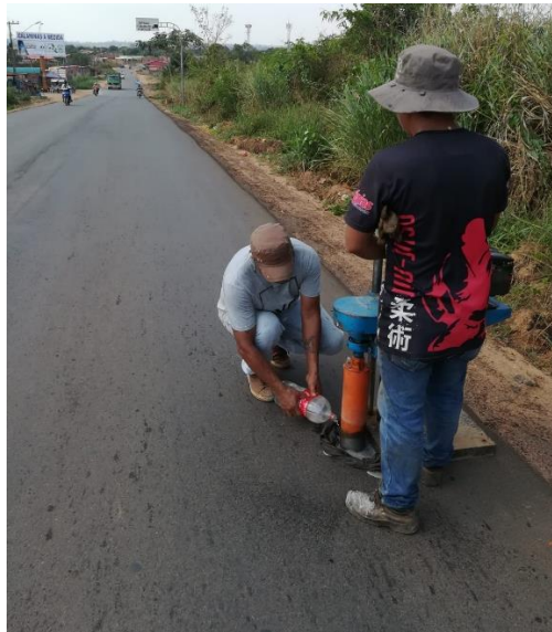
Figura 73. Extracción de núcleos para el control de calidad
