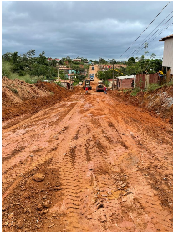
Figura 30. Perfilado y nivelado de la subrasante
