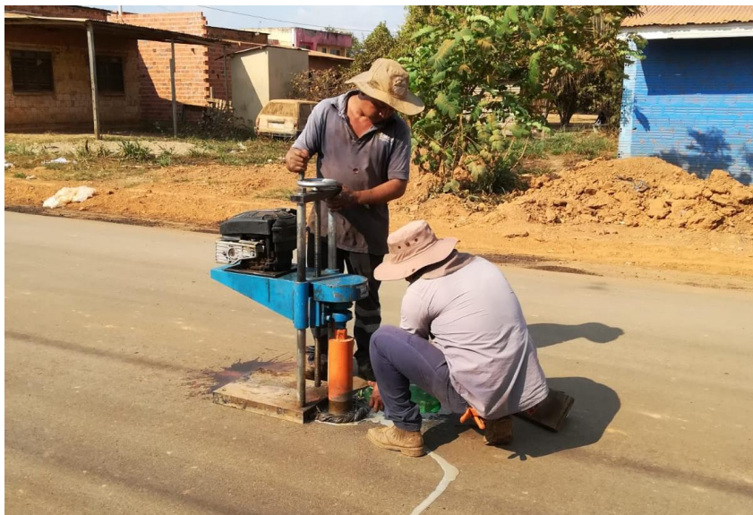
Figura 64. Extracción de núcleos para el control de calidad
