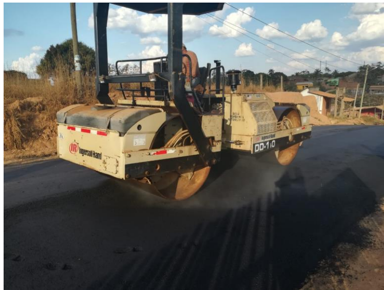
Figura 13. Compactador de asfalto de rodillo liso INGERSOLL RAND DD-110 Fuente: Elaboración propia
