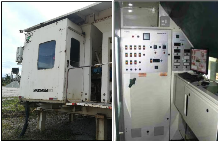
Figura 102. Cabina de mando
