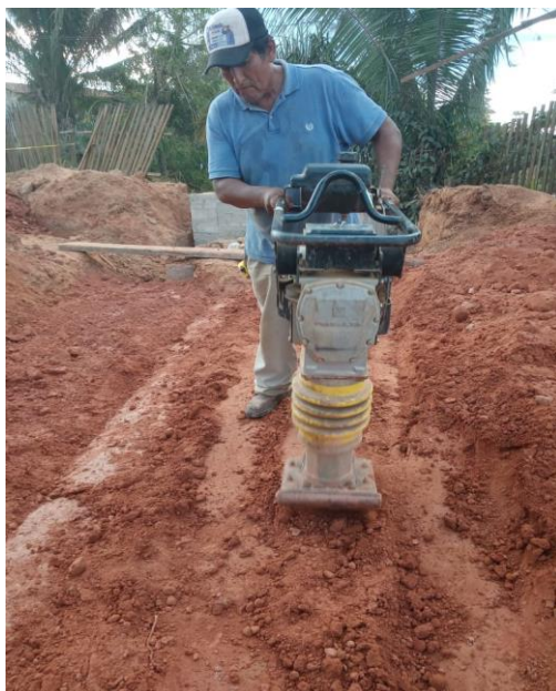
Figura 44. Relleno y compactado de material laterítico
