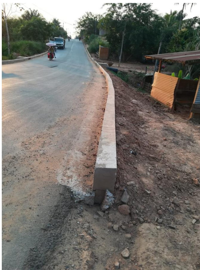
Figura 49. Acabado final del cordón y cuneta
