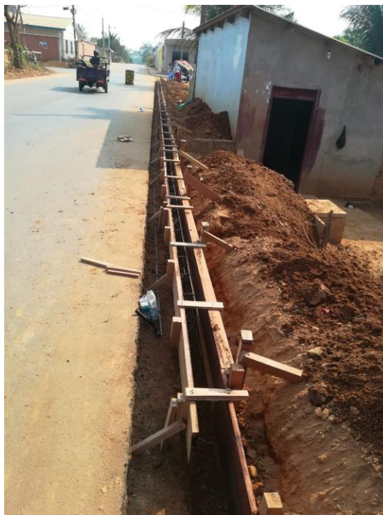
Figura 48. Encofrado y armado para cordones y cunetas
