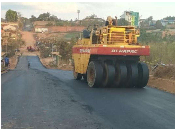
Figura 14. Compactador de asfalto de rodillo neumático DYNAPAC CP-271 Fuente: Elaboración propia
