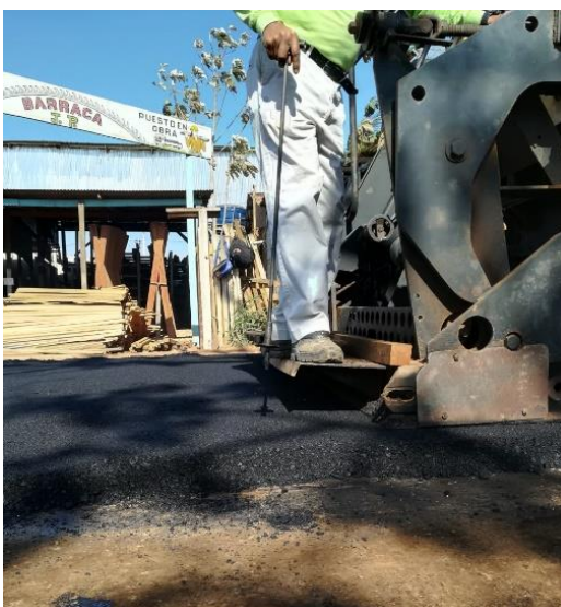
Figura 69. Control del espesor del pavimento
