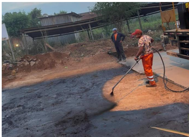
Figura 76. Riego de imprima para bacheo
