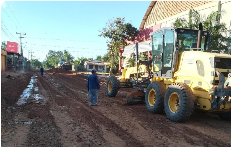
Figura 6. Motoniveladora perfilando la subrasante
