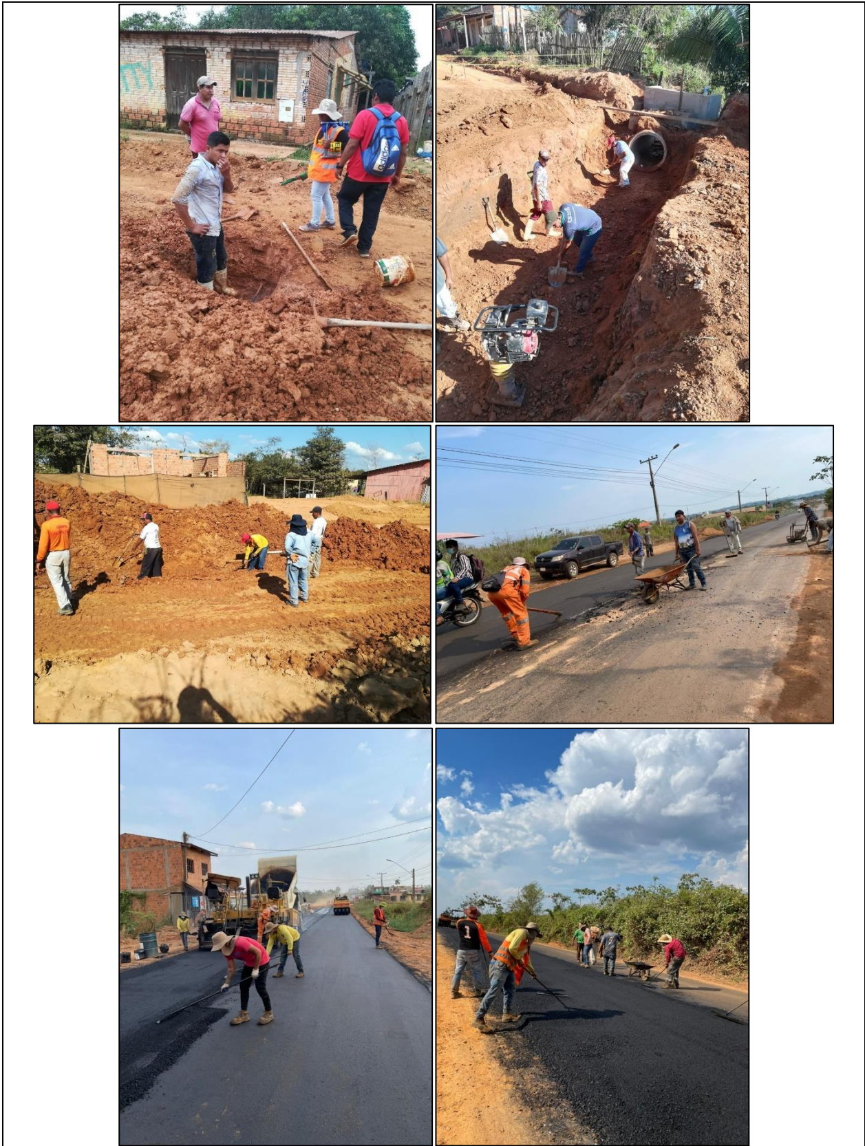
Figura 100. Ejecución con la mano de obra mínima requerida
