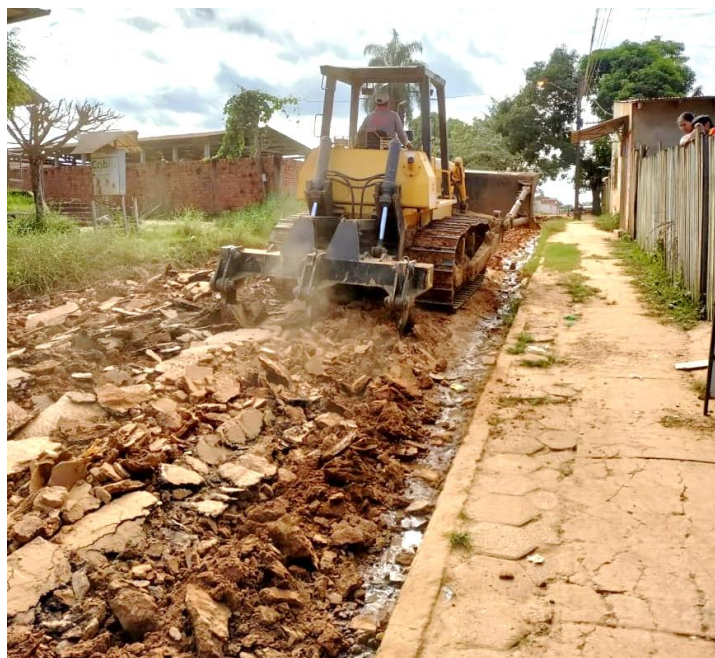
Figura 29. Retiro de la capa asfáltica
