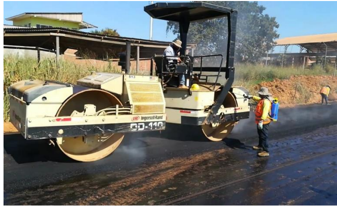
Figura 54. Roseado de diésel a rodillo liso del compactador de pavimento Fuente: Elaboración propia
