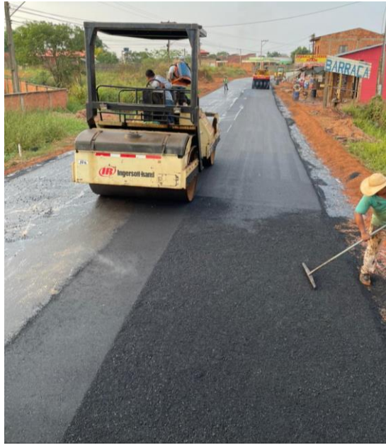
Figura 72. Compactado del recapado
