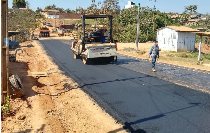
Figura 63. Compactado del pavimento
