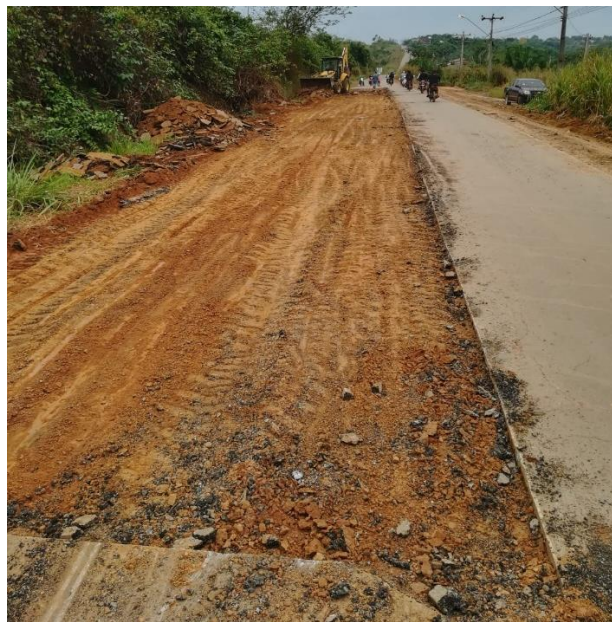
Figura 75. Retiro de capa de rodadura dañada para realizar el bacheo profundo Fuente: Elaboración propia
