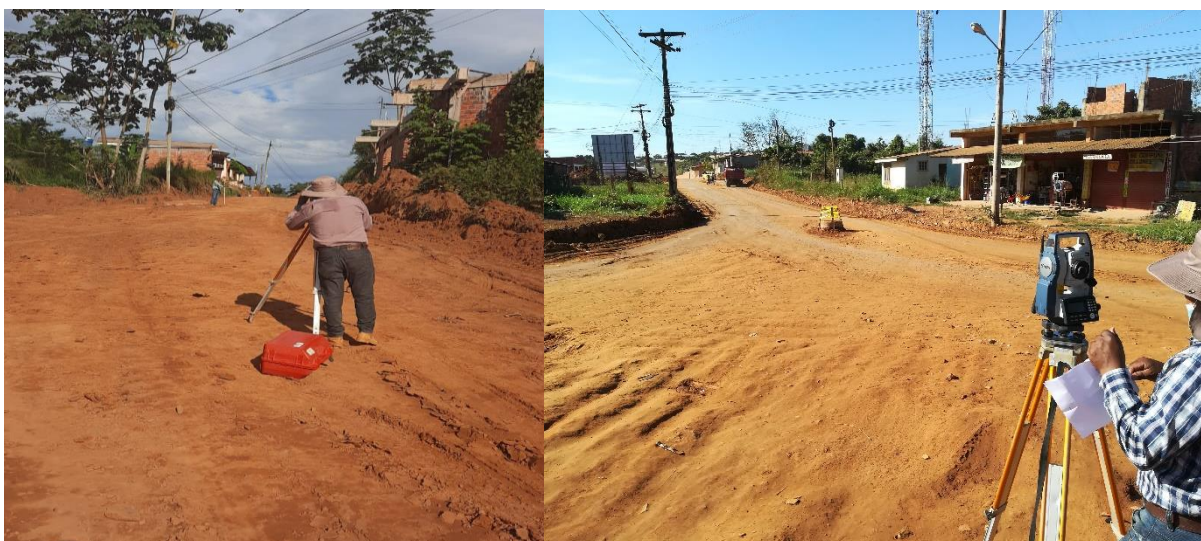
Figura 22. Control topográfico para nivelación de plataforma
