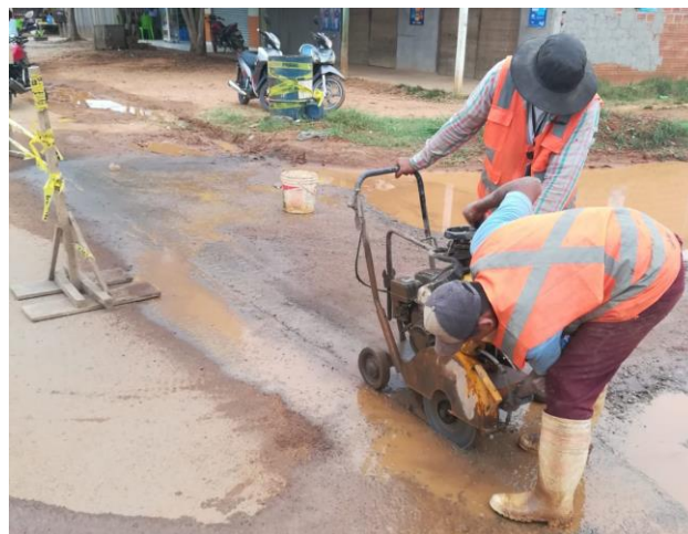
Figura 74. Cortado del pavimento para el bacheo profundo
