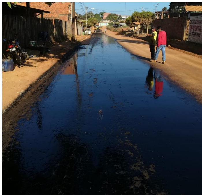
Figura 58. Proceso de imprimación
