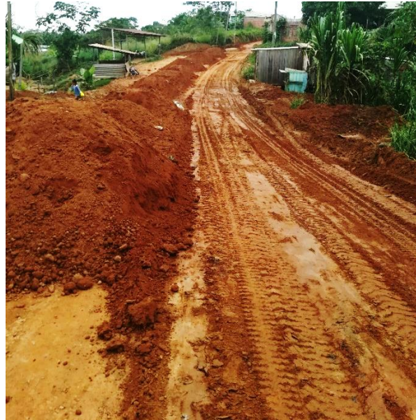
Figura 33. Acopio de material laterítico para capa base
