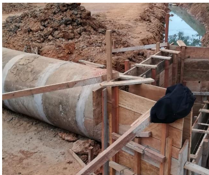
Figura 46. Tendido de tubos de hormigón armado de diámetro igual a 1000mm Fuente: Elaboración propia
