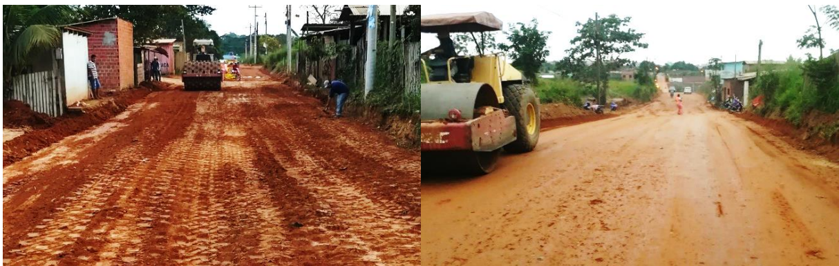
Figura 35. Compactado de capa base Fuente: Elaboración propia
