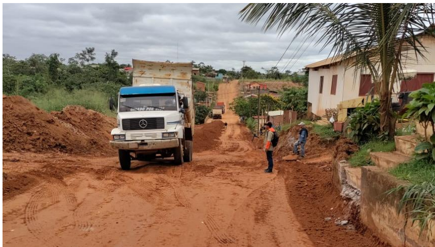
Figura 7. Camión volquete descargando material laterítico
