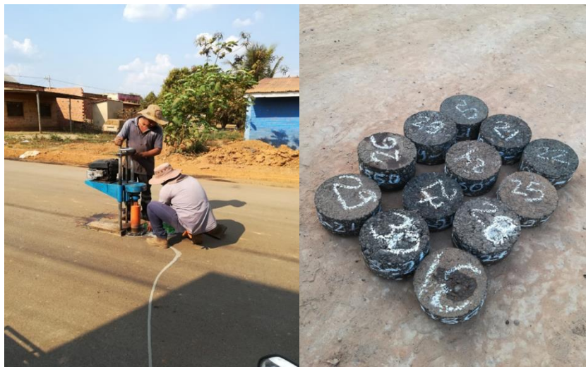
Figura 98. Extracción de núcleos
