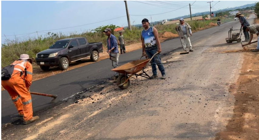
Figura 70. Corte del borde del recapado
