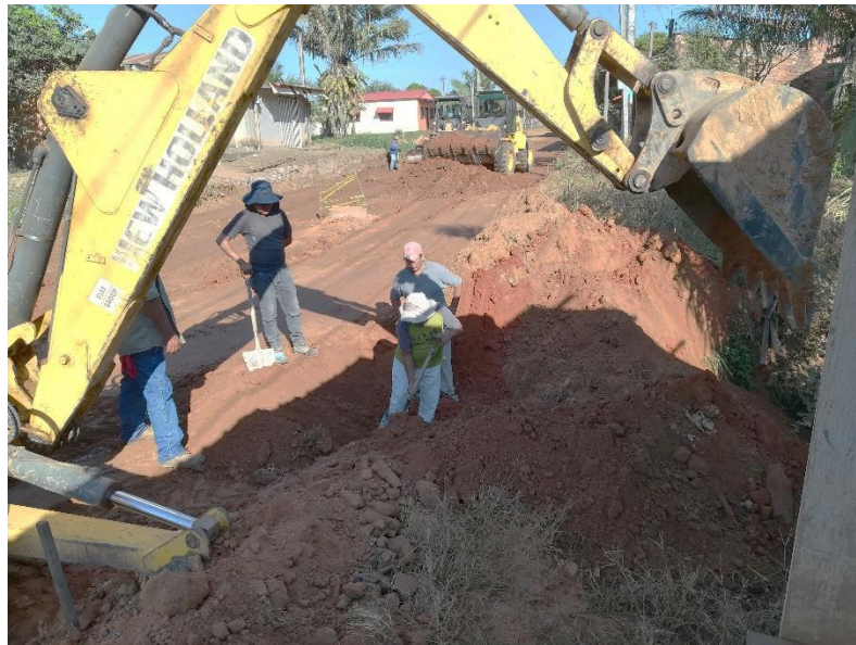
Figura 39. Excavación para cabezal de hormigón armado
