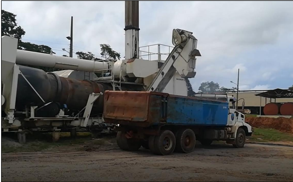
Figura 113. Vaciado de mezcla asfáltica en camión volquete Fuente: Elaboración propia
