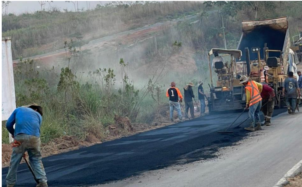
Figura 68. Proceso de recapado
