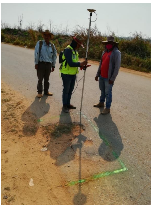
Figura 66. Levantamiento y replanteo topográfico
