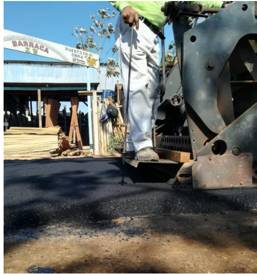
Figura 60. Control del espesor del pavimento
