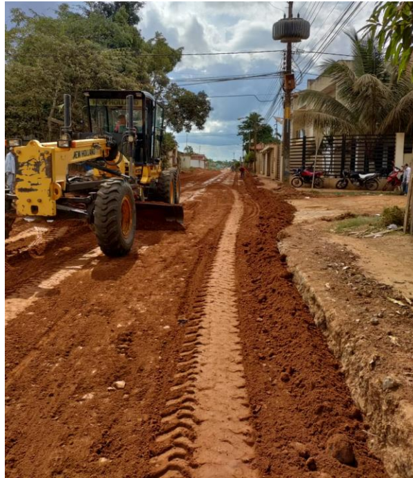
Figura 34. Distribución de material laterítico mediante Motoniveladora Fuente: elaboración propia
