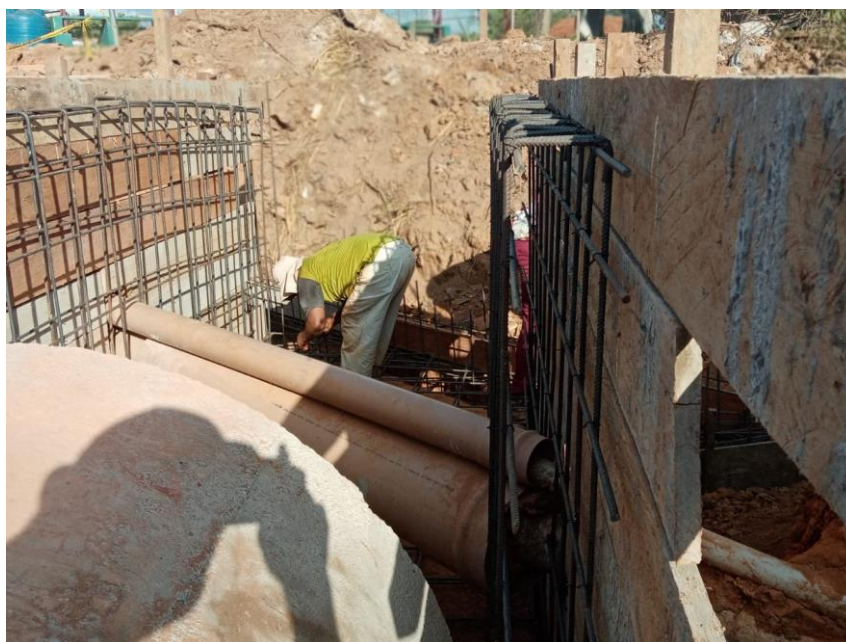
Figura 41. Encofrado y armadura para cabezal de hormigón armado Fuente: Elaboración propia
