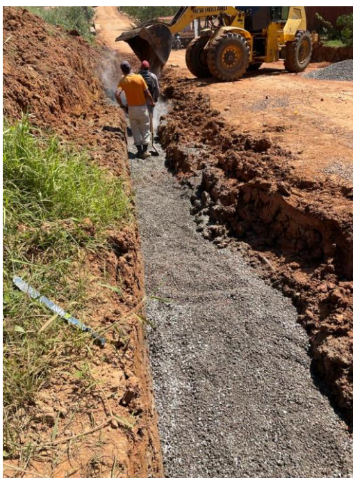
Figura 40. Material granular conformando un sub-dren
