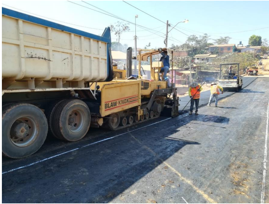
Figura 59. Proceso de pavimentación
