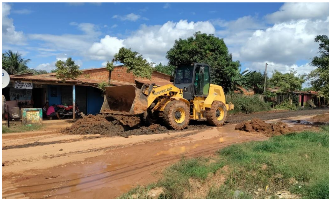
Figura 3. Cargador frontal trabajando en conjunto con camión volquete
