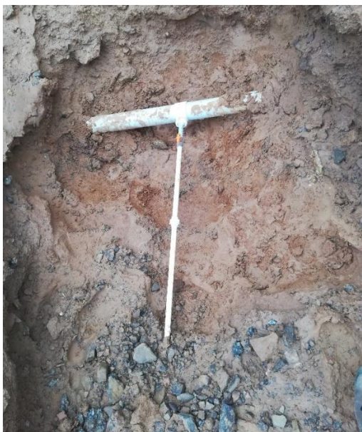
Figura 32. Reparación de acometida de agua potable
