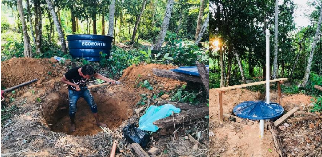
Foto N°3 Excavación y construcción del tanque de almacenamiento
