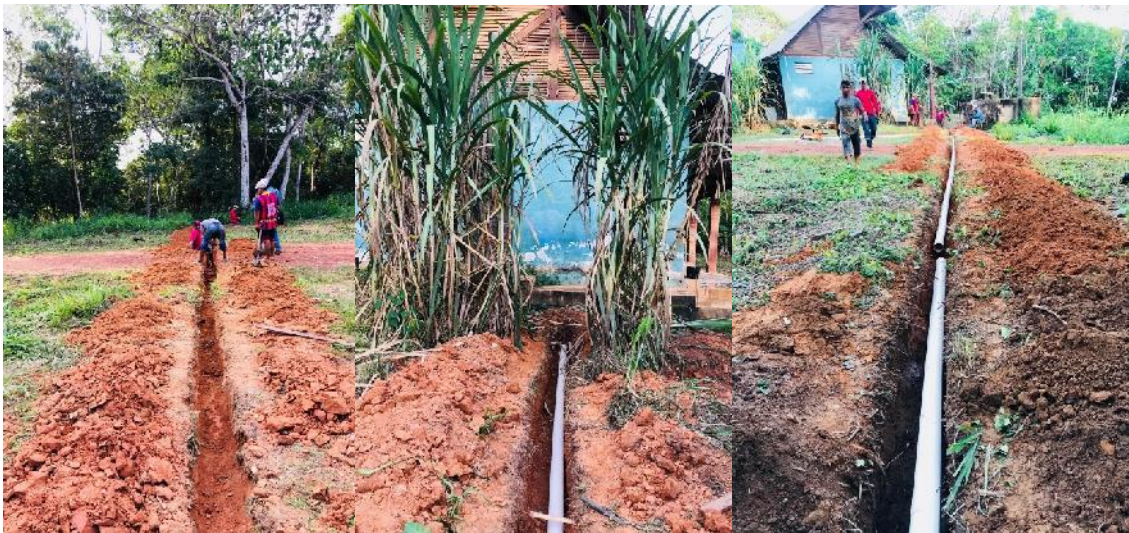
Foto N°2 Excavación y tendido de tubería PVC de 4”
