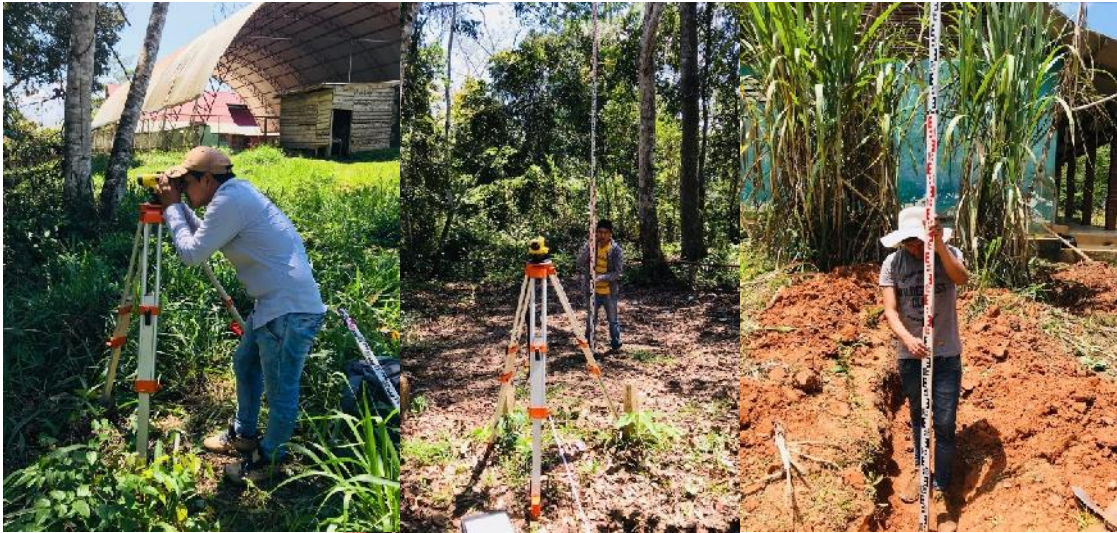
Foto N°1 Estudio topográfico en el área de construcción del lombrifiltro
