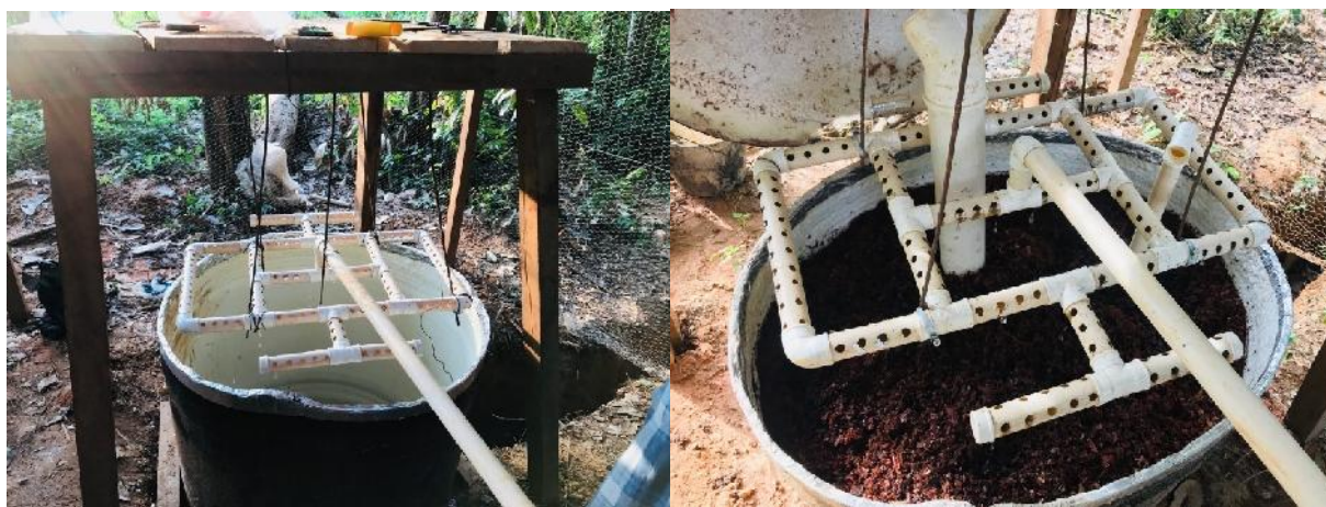
Figura 3.13. Rociado del afluente en la superficie del lombrifiltro
