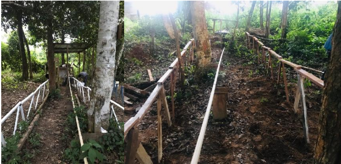
Foto N°7 Protección a las tuberías de PVC que llevan las aguas crudas al lombrifiltro
