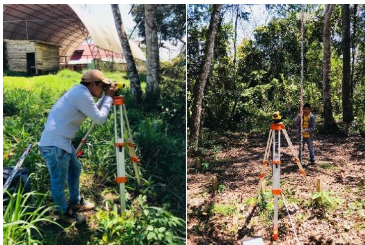
Figura 3.8. Replanteo y control lineal
