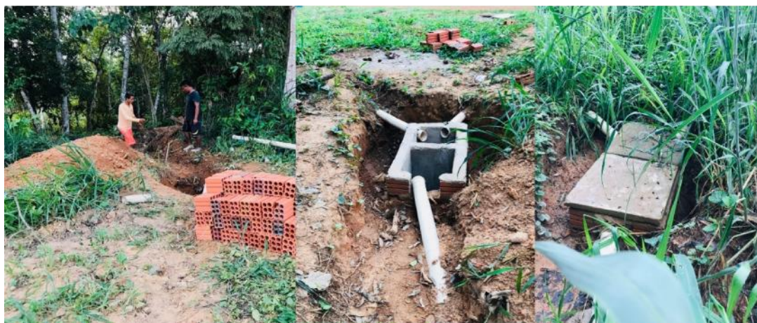
Figura 3.11. Cámara de separador de solidos
