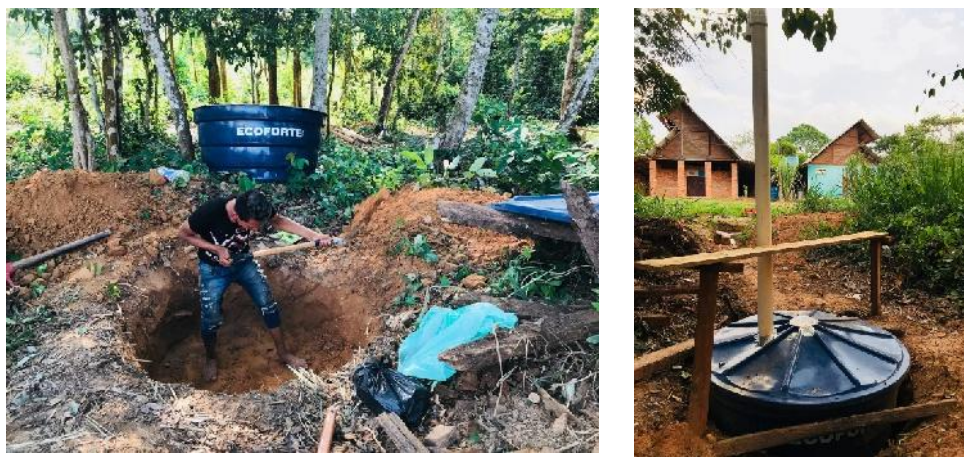
Figura 3.12. Instalación de Tanques de almacenamiento
