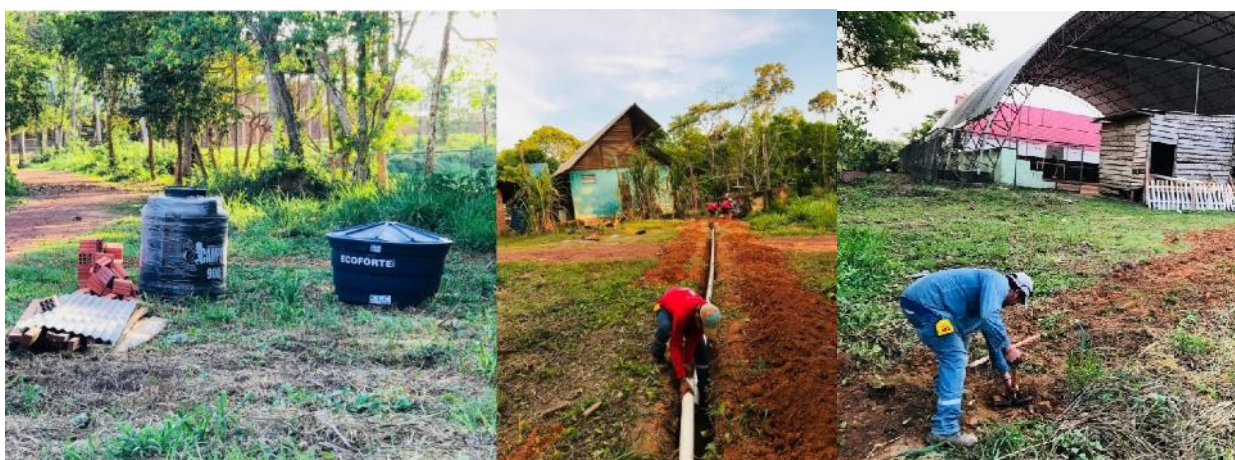
Figura 3.10. Provisión y tendido de tubería PVC de 4"
