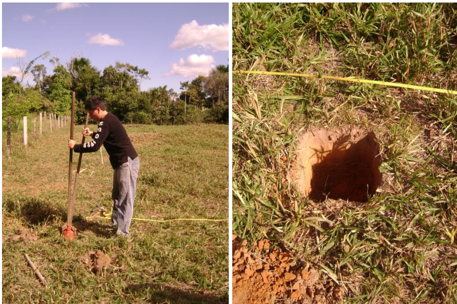
Foto N° 7. Excavación de hoyos
