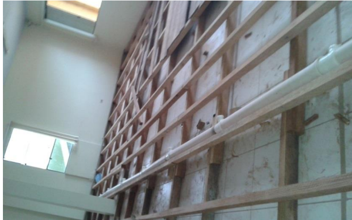
Ilustración 23 Tendido de los ductos Fuente: Elaboración propia
