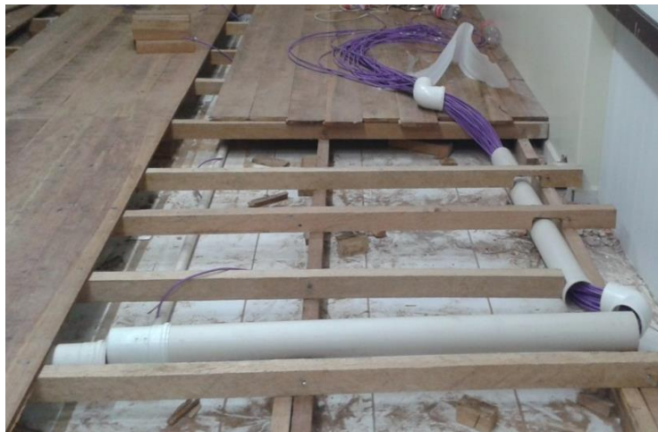
Ilustración 24. Tendido del cable UTP categoría 6a Fuente: Elaboración propia
