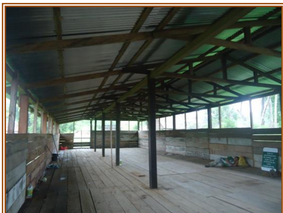
Galpón bien construido PI San José
