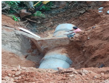
Figura 2.14 Tubo de hormigón de \Phi 1000 mm
