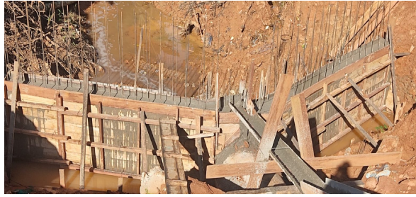
Figura 2.15 Encofrado y Vaciado de Aleros
