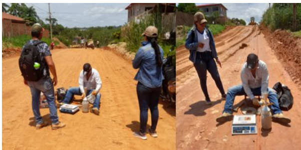
Figura 3.15 Ensayo de densidad in situ "método de cono de arena"
