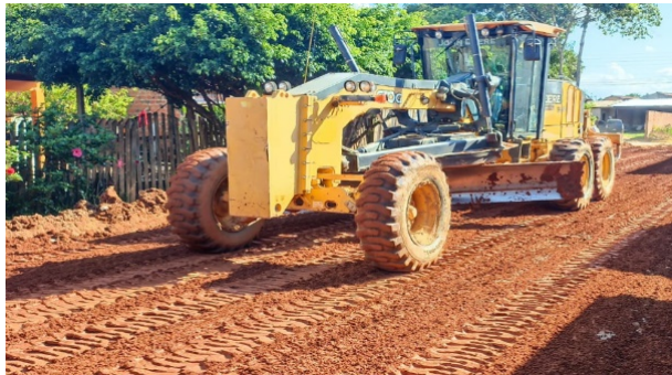
Figura 2.5 Esparcido y Escarificado
