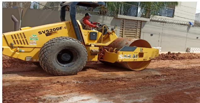
Figura 2.8 Compactado de la Capa Base (suelo cemento)
