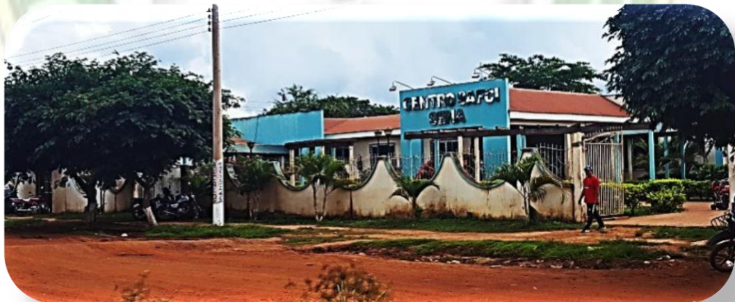
Fotografía 6: Fachada principal C.S. “EL SENA”. Fuente: Propia.
