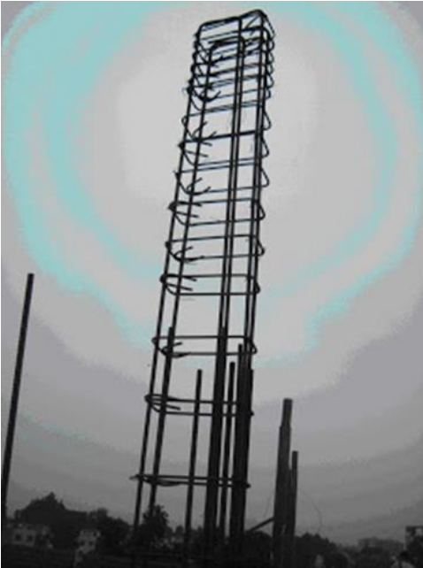
Figura 7 Armado de Columna con barras de hierro
