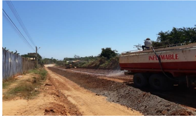
Figura 2.30 Mezclado de suelo - cemento
