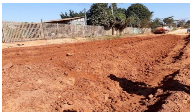
Figura 2.27 Procesado de material para capa base
