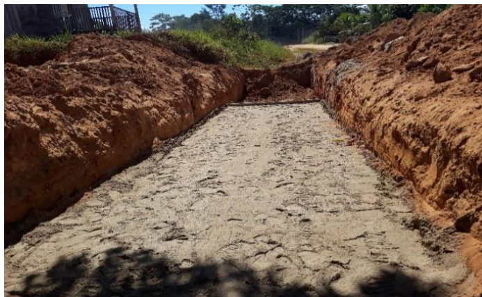
Figura 2.49 Colocado de cama de arena
