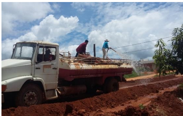
Figura 2.22 Procesado de material para capa sub-base
