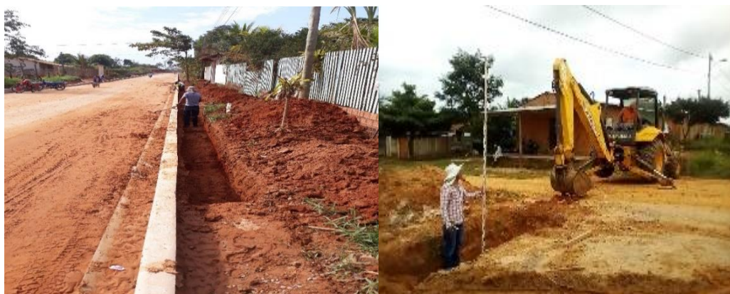
Figura 2.48 Excavación manual y con maquinaria para drenaje
