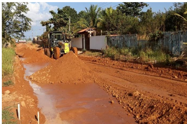
Figura 2.21 Regado y extendido de material
