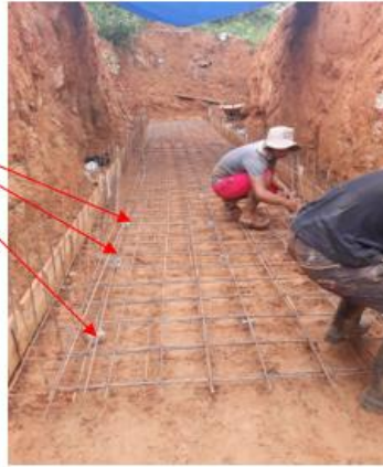
Figura 2.50 Colocado de armadura drenaje Prog. 0+750
