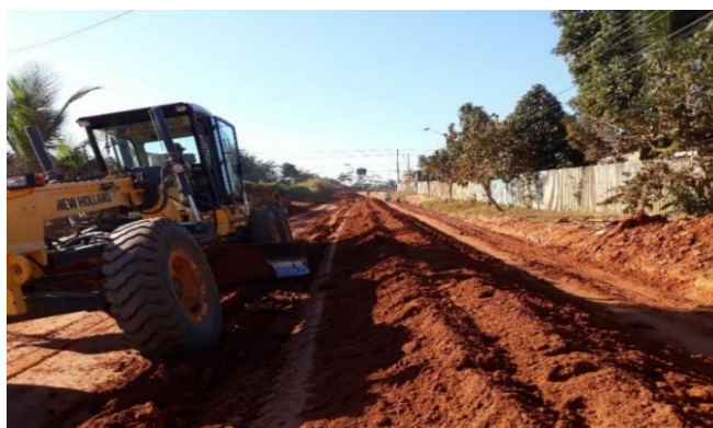
Figura 2.28 Acoronado de material para capa base
