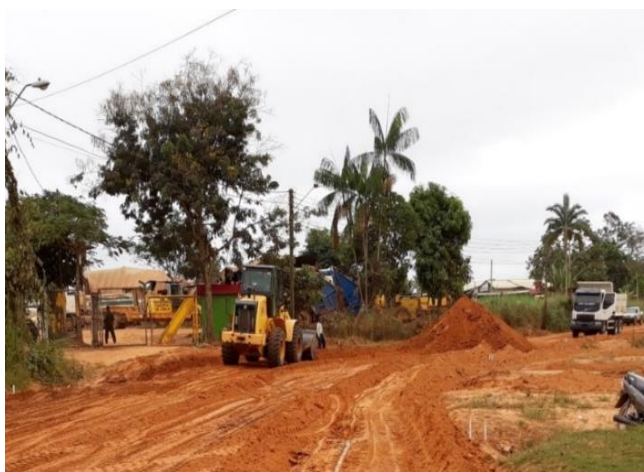
Figura 2.19 Transporte de material de corte
