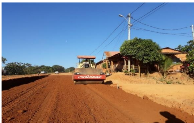
Figura 2.23 Sellado de la capa sub-base
