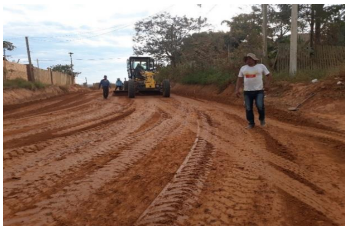
Figura 2.24 Nivelado de la capa sub-base
