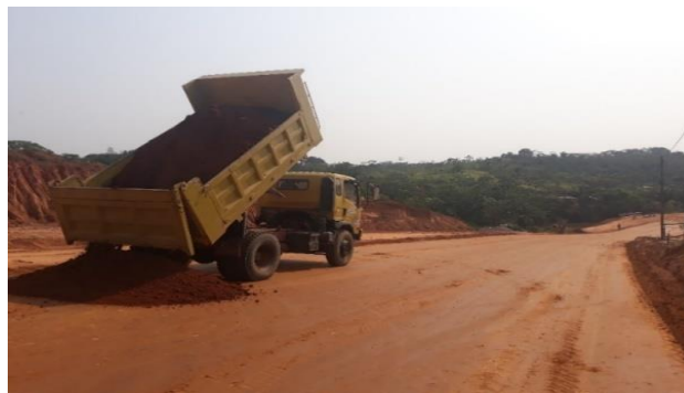
Figura 2.26 Acopio de material para capa base
