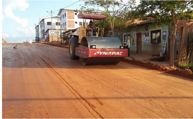
Figura 2.25 Compactación final de la capa sub-base
