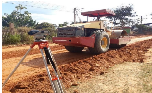
Figura 2.31 Sellado de la capa base suelo - cemento
