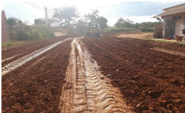
Figura 2.18 Escarificado del terreno natural
