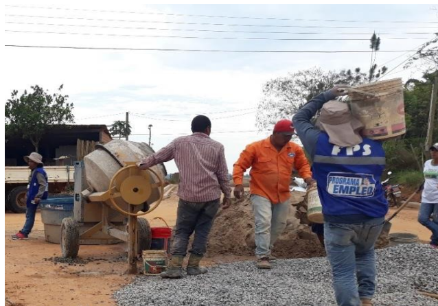
Figura 2.52 Preparación del hormigón “in situ”
