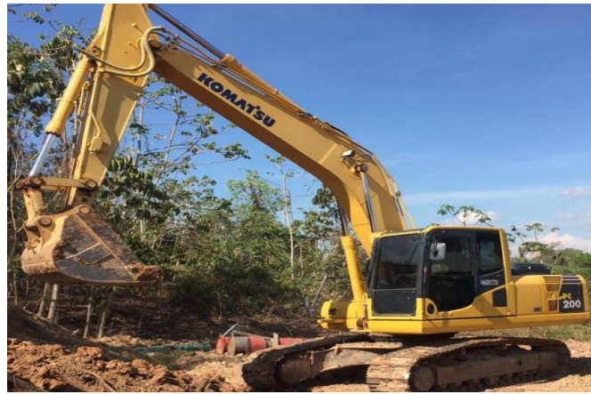
Figura 2.11 Excavadora sobre orugas Komatsu PC200
