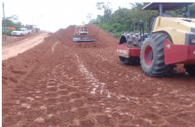
Figura 2.16 Corte y terraplenado
