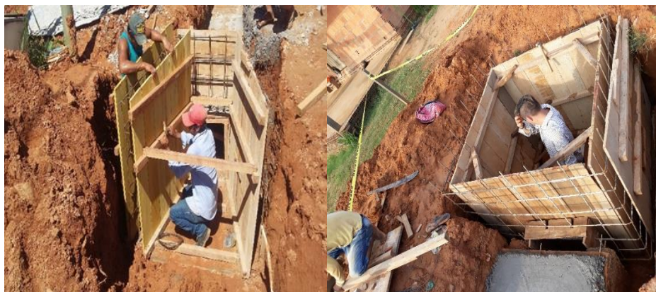
Figura 2.51 Encofrado de cabezal y cámara para drenajes
