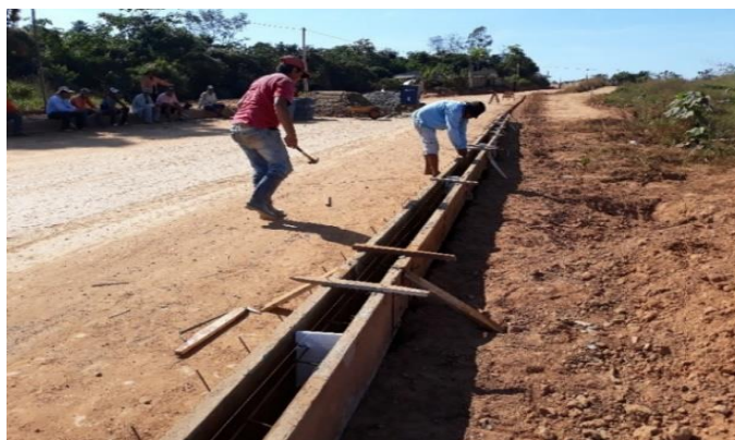
Figura 2.36 Encofrado de cordones
