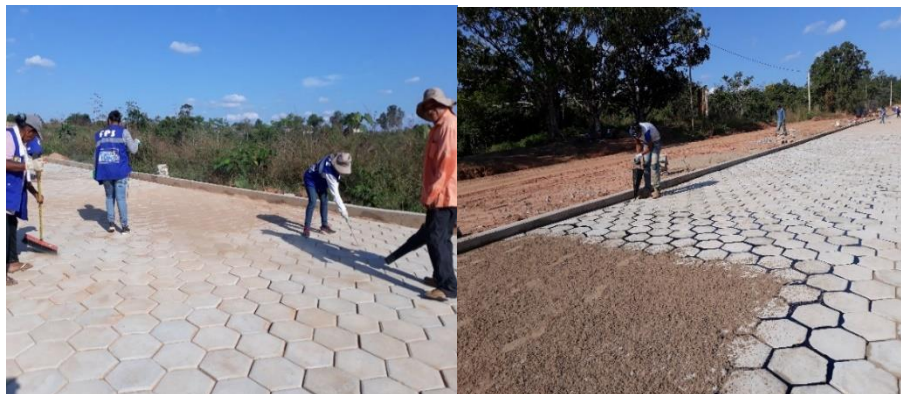
Figura 2.40 Limpieza y sellado de juntas
