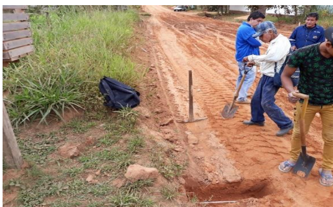
Figura 2.17 Profundización de red de agua
