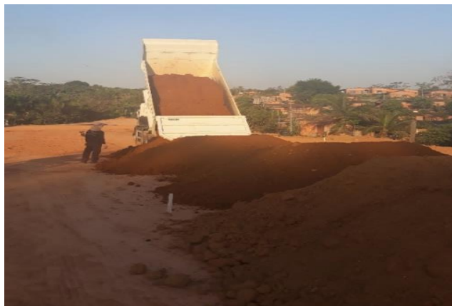
Figura 2.20 Acopio de material sobre la subrasante
