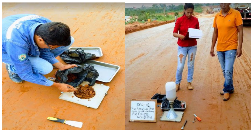
Figura 3.9 Ensayo de densidad in situ “método de cono de arena” Fuente: Elaboración propia
