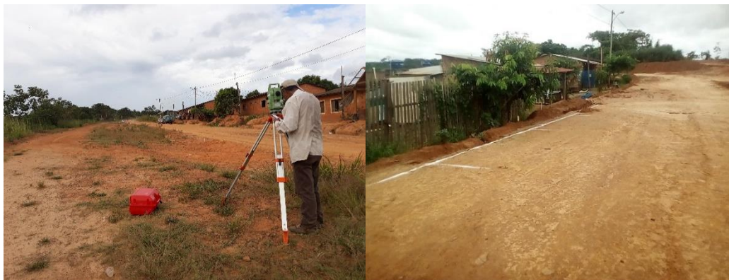
Figura 2.47 Replanteo y trazado de drenaje
