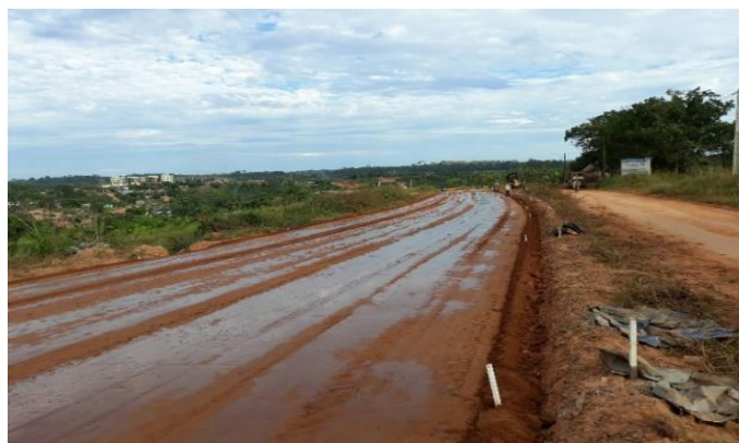
Figura 2.34 Curado de la capa base suelo - cemento
