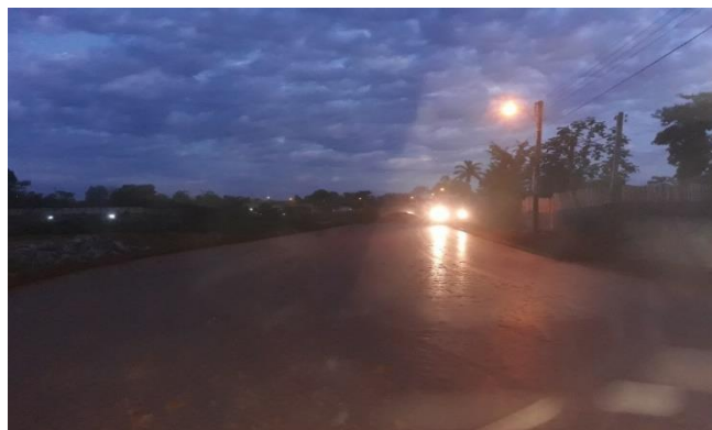
Figura 2.33 Compactado final de capa base Fuente: Elaboración propia
