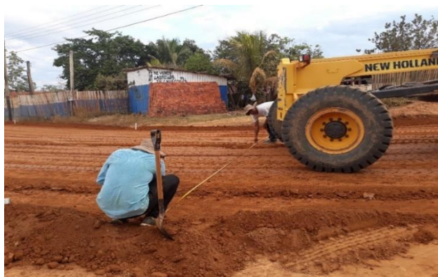
Figura 2.32 Nivelado y perfilado de la capa base Fuente: Elaboración Propia
