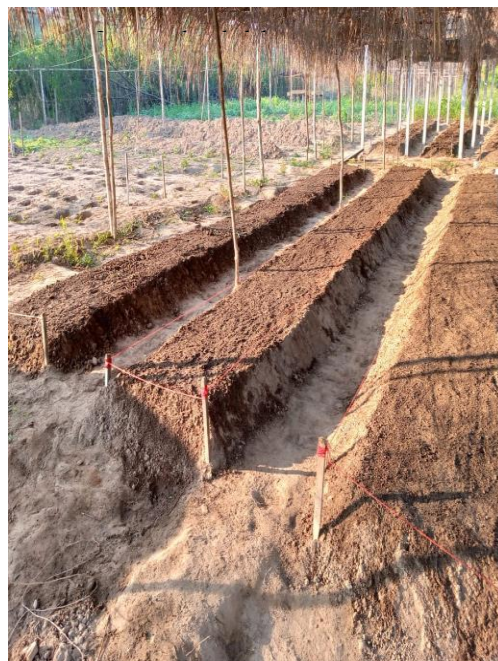
Anexo 4: Nivelación del lugar Fuente: Elaboración propia
