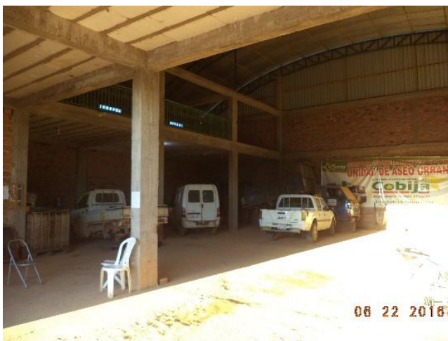
Foto 19. Ambiente sin ningún tipo de señalización
