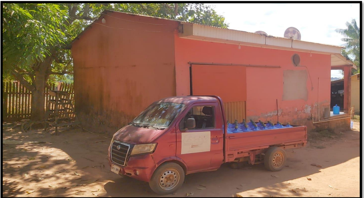
Figura 8. Instalaciones de la planta comunidad de Avaroa perteneciente al municipio de Cobija-Pando Fuente: Elaboración propia
