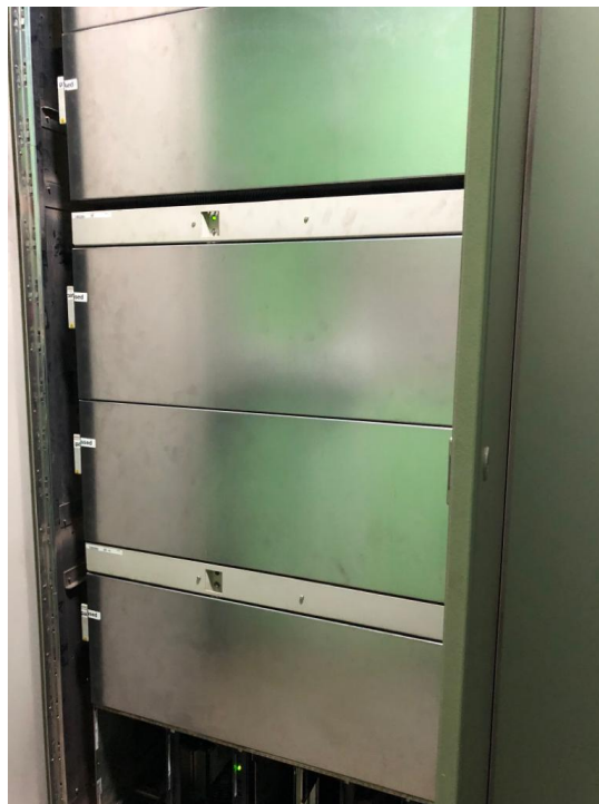
Figura 35. Instalación de nuevo servicio de Tv Cable
