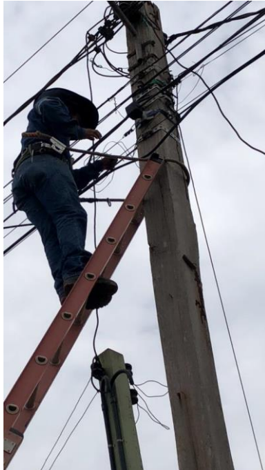
Figura 32. Tecnico de Coteco instalando nuevo servicio de Tv Cable
