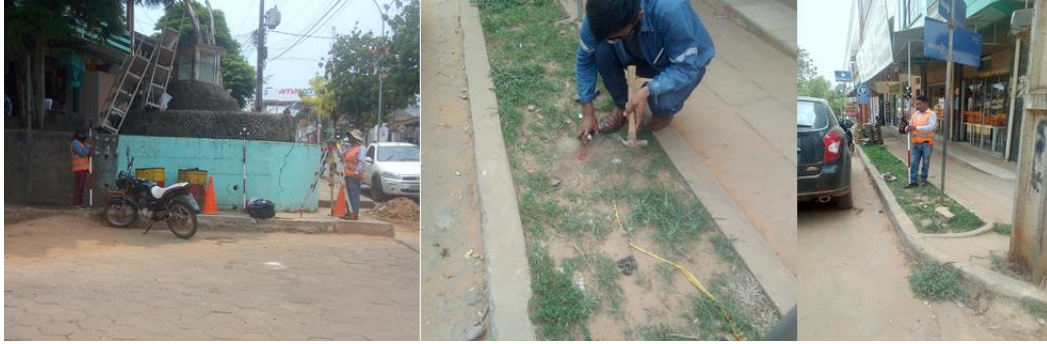
Figura 3.2. Trabajo de campo topografía
