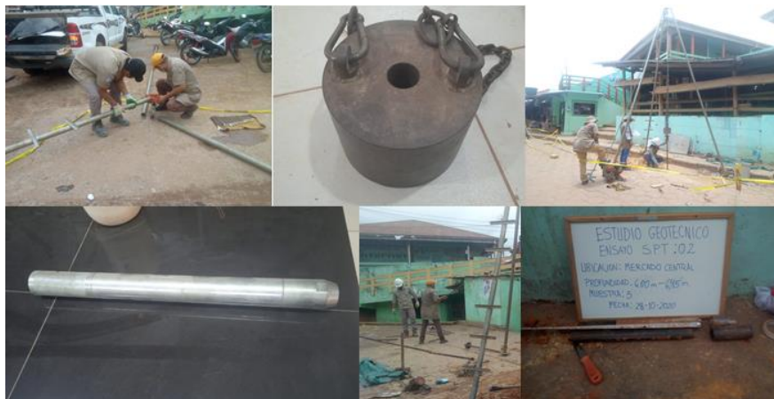
Figura 3.5. Trabajo de campo ensayo SPT Mercado Central
