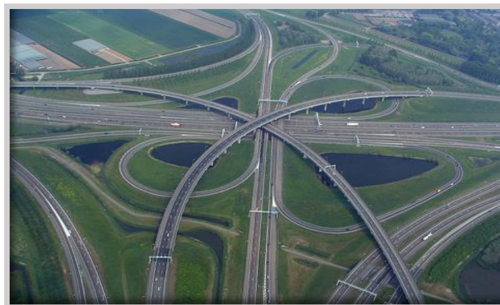
Figura 3.8. Intersección a Desnivel. Fuente: wikiwand.com/Imagen Paso a desnivel
