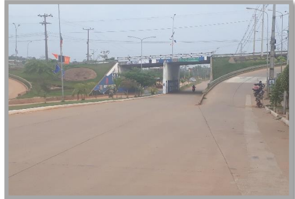
Figura 1.4. Paso a Desnivel- Salida Terminal Aeroportuaria Fuente: Foto In - Situ
