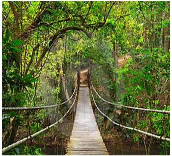
CON LA CONSTRUCCION MEJORADA (Puente)
