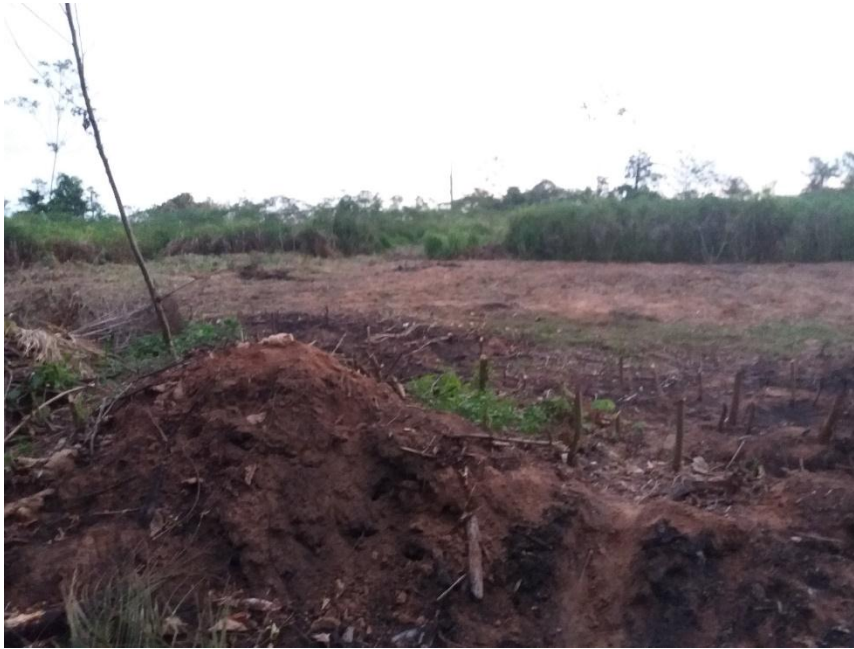
Figura 2. Habilitación del área
