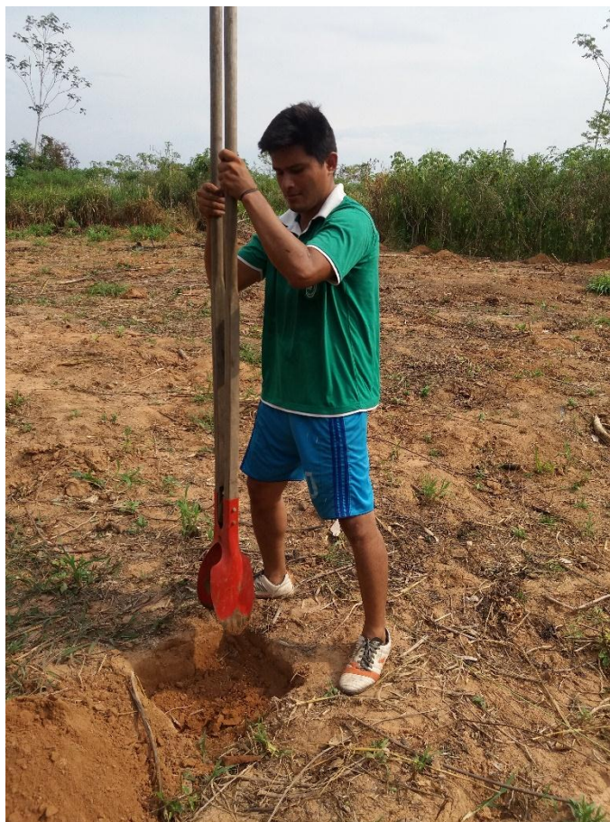
Figura 3. Excavación de hoyos
