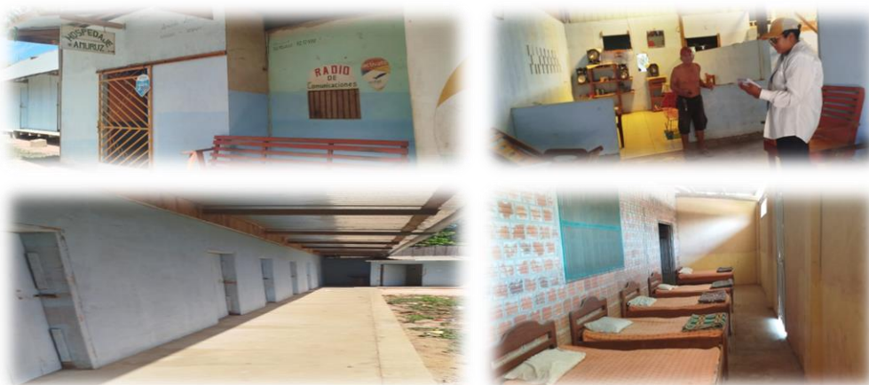
Figura 40. Alojamiento Amurúz Fuente: propia
