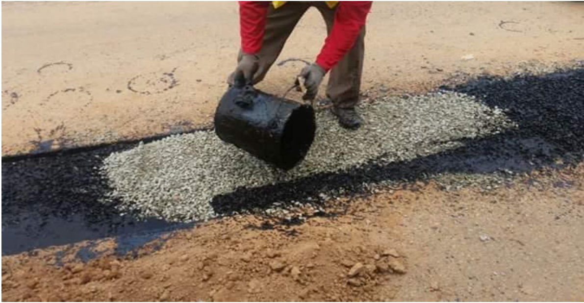
Figura 57: Trabajo de bacheado 3 Fuente: Millenium Grass Cobija
