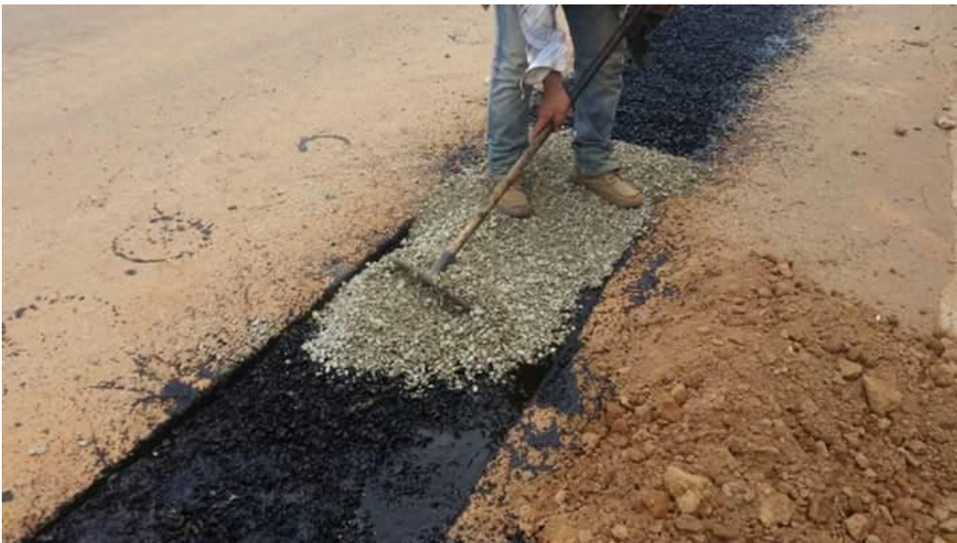
Figura 56: Trabajo de bacheado 2 Fuente: Millenium Grass Cobija
