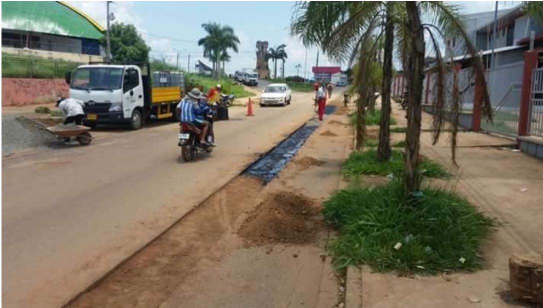
Figura 55: Trabajo de bacheado 1 Fuente: Millenium Grass Cobija
