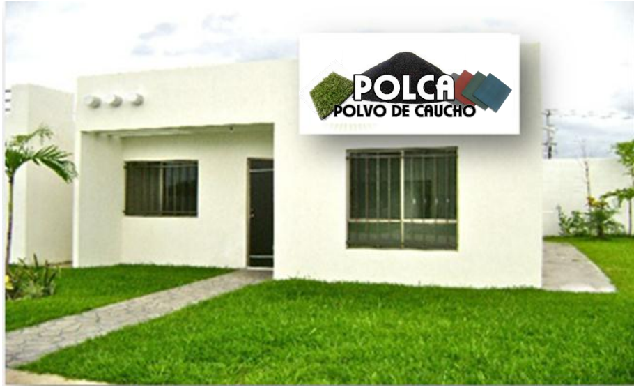
Figura 27: Fachada principal POLCA Fuente: Elaboración propia
