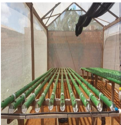
Anexo Nro. 5: preparación del sistema NFT Fuente: Elaboración propia
