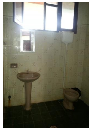
FIGURA N°31: baño de la vivienda
