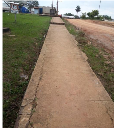
FIGURA N°22: no existe señalización en las vías de circulación.
