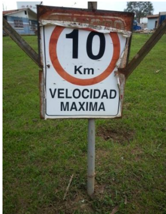
FIGURA N°18. Señal de panel deteriorada
