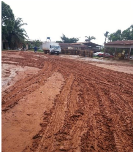
FIGURA N°21: no existe señalización en las vías de circulación vehicular.
