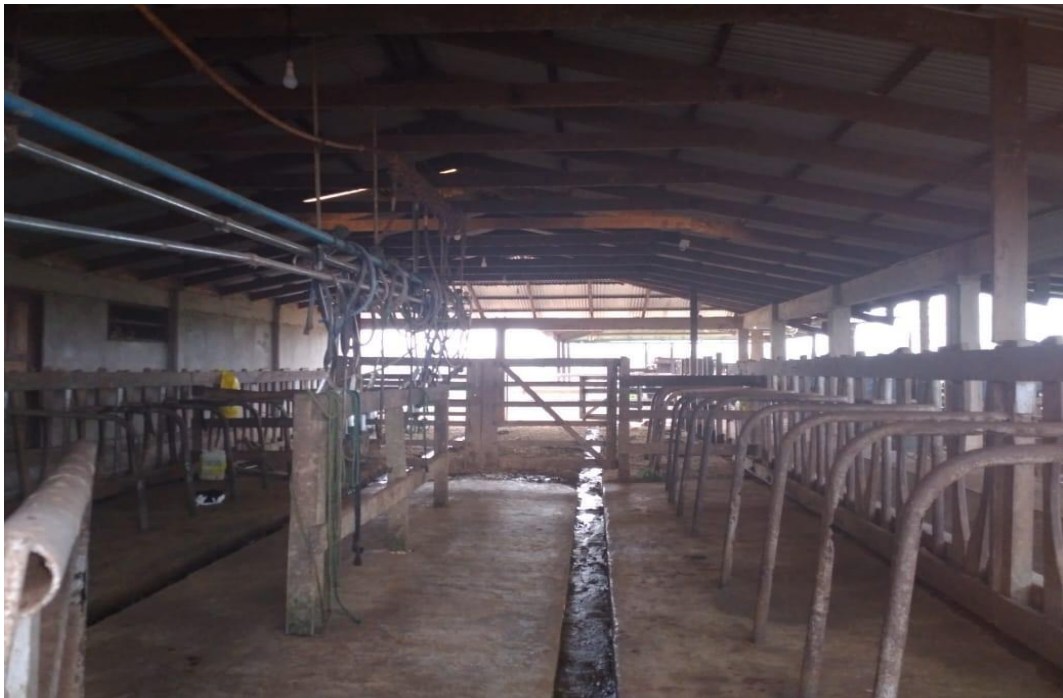
Figura 7 Infraestructura de ordeña granja Arroyo Lácteos
