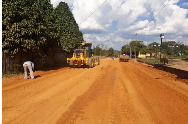
Figura 2.33 Nivelación de la capa sub base
