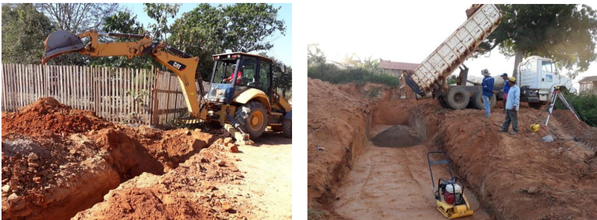
Figura 2.44 Maquinaria pesada para drenajes pluviales
