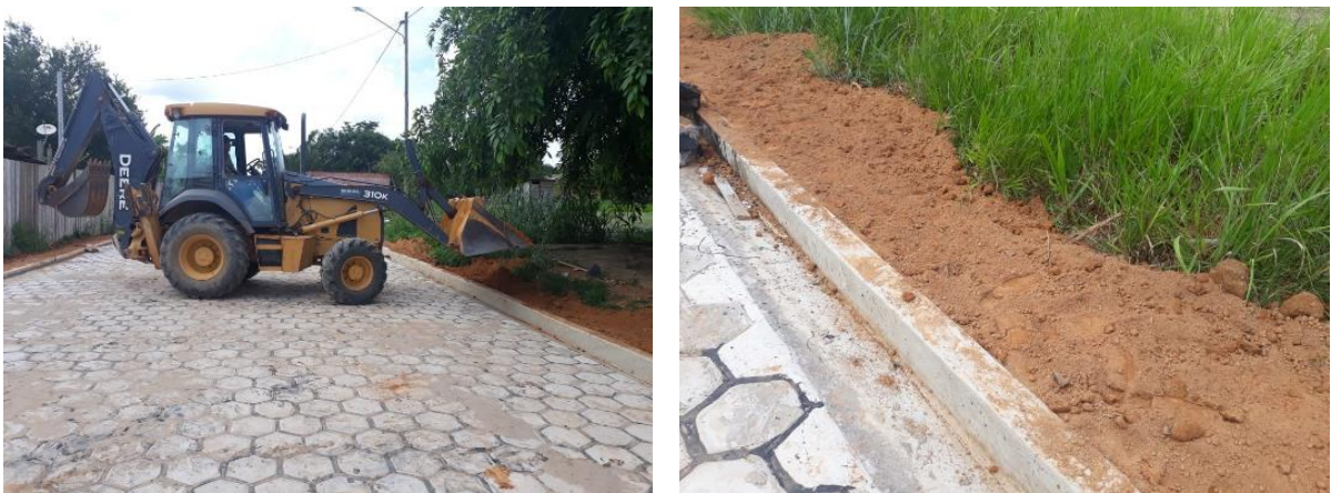
Figura 2.59 Relleno de aceras con material laterítico
