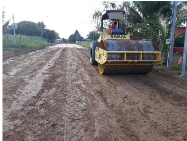
Figura 2.37 Compactación de la capa base
