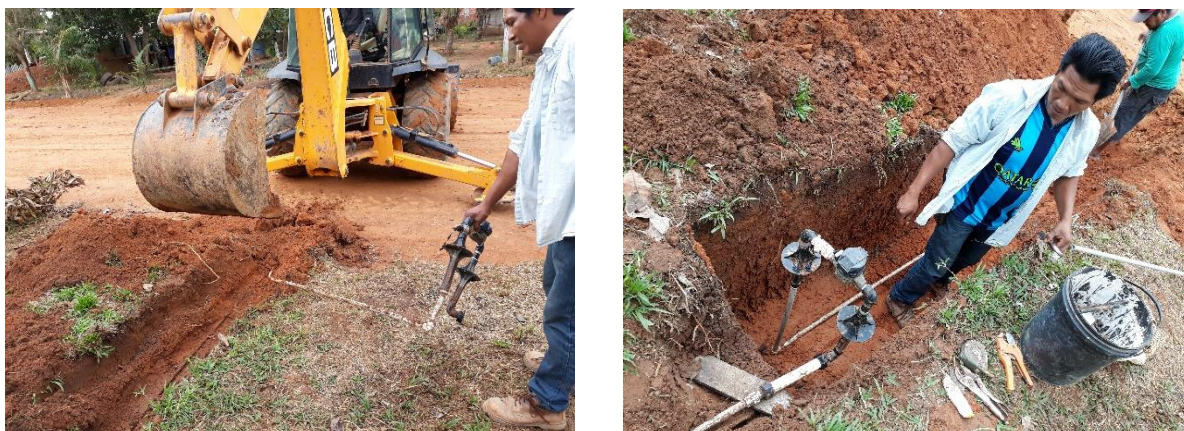
Figura 2.5 Reubicación de acometidas de la red de agua potable
