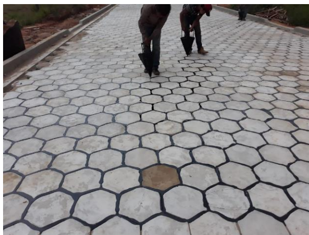
Figura 2.65 Sellado de juntas
