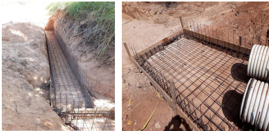
Figura 2.50 Colocado de armaduras en obras de arte
