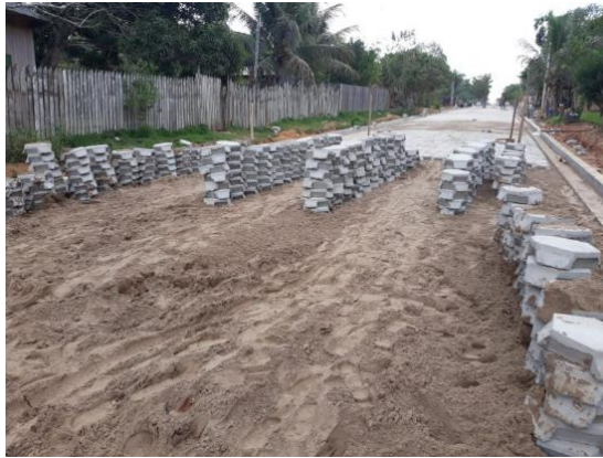
Figura 2.61 Acopio del material para enlosetado
