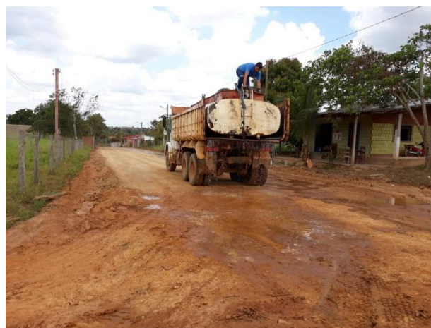
Figura 2.38 Curado de la capa base
