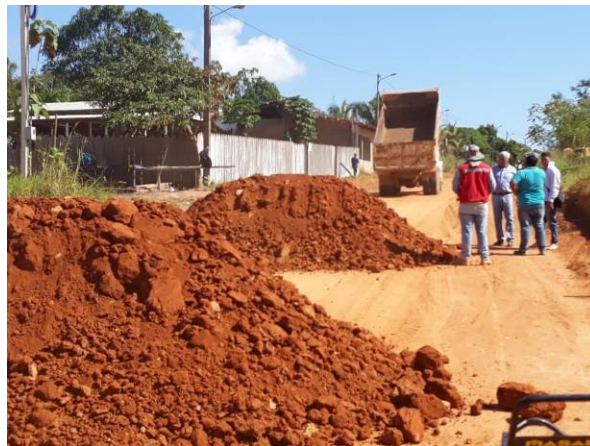
Figura 2.30 Acopio del material lateritico
