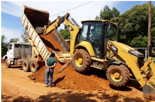
Figura 2.19 Retro excavadora – CAT 416F2
