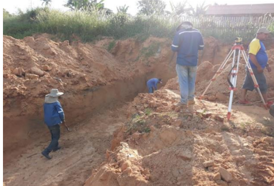
Figura 2.47 Excavación para drenaje pluvial
