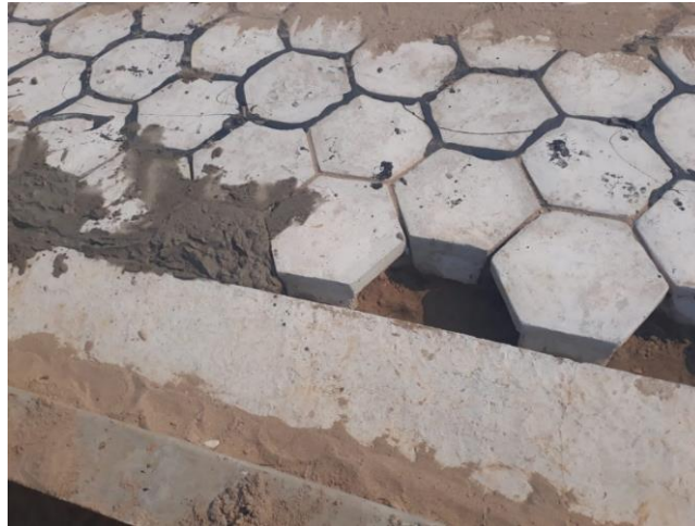
Figura 2.64 Vaciado de remates
