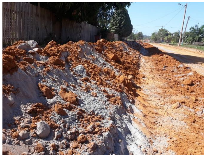
Figura 2.35 Mezclado del suelo cemento
