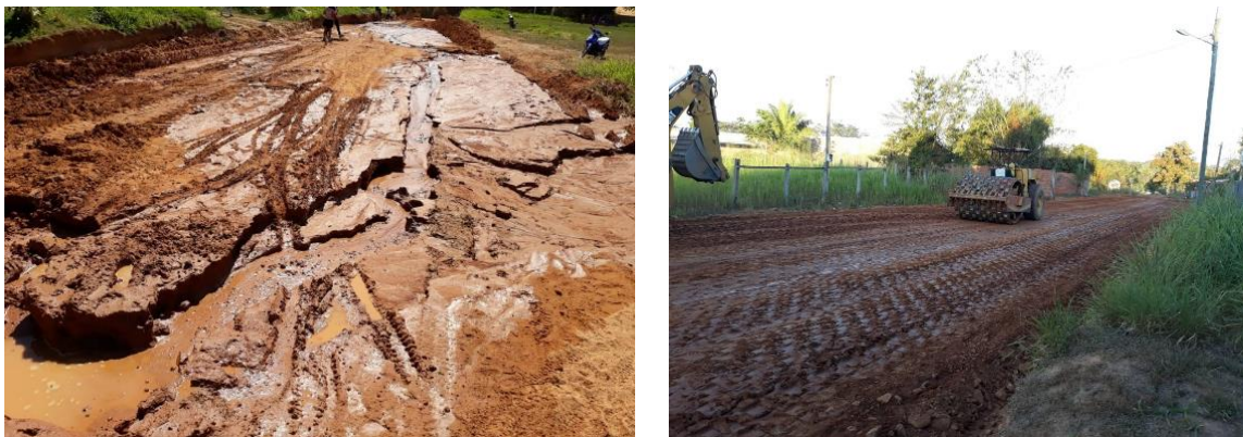
Fig. 2.39 Cambio de material para subrasante
