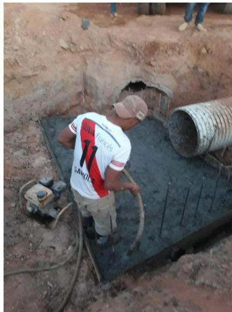
Figura 2.53 Vibrado del hormigón de obras de arte
