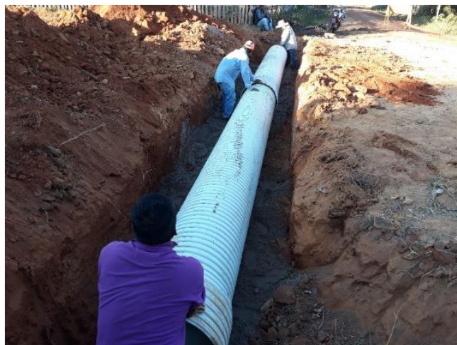
Figura 2.48 Tendido de tuberías de PVC
