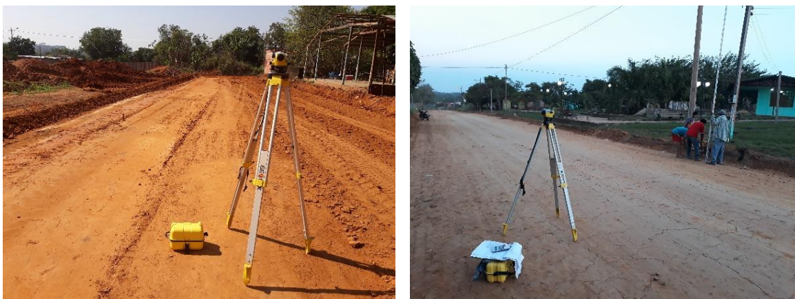
Figura 2.9 Nivelación de la plataforma
