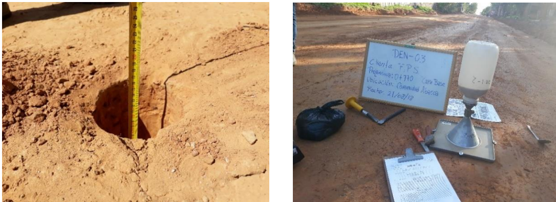
Figura 3.6 Ensayo de densidades en campo (Cono de Arena)
