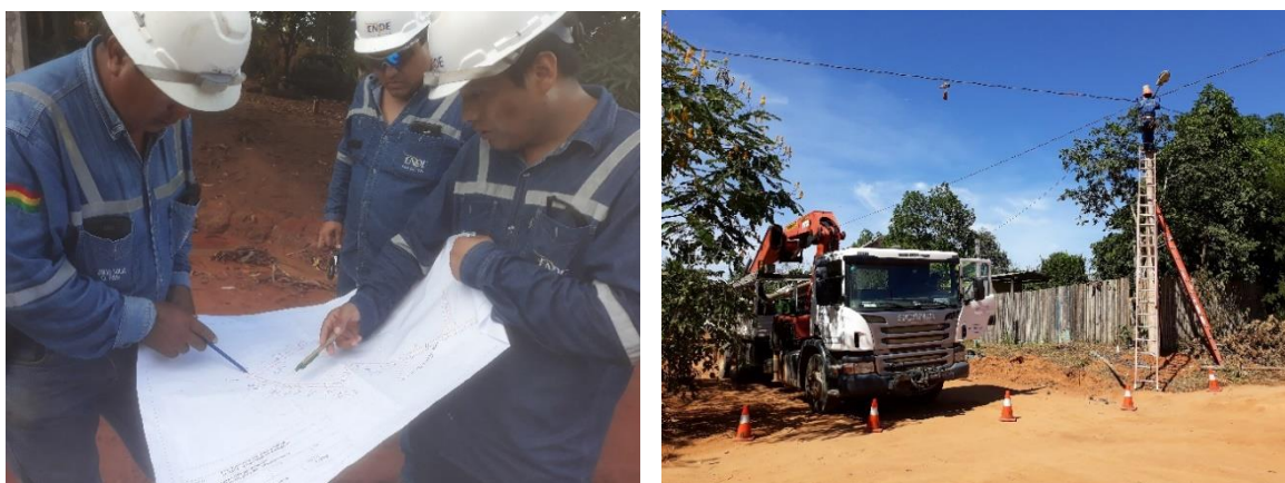
Figura 2.2 Reubicación de postes de energía eléctrica
