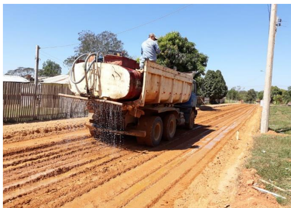
Figura 2.32 Regado del material con camión cisterna
