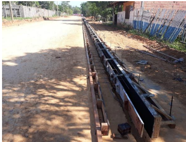
Figura 2.56 Encofrado de cordón cuneta
