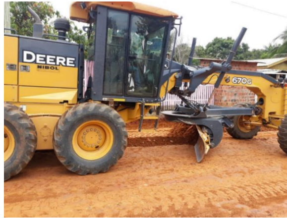
Figura 5.4 Corte con cuchilla invertida
