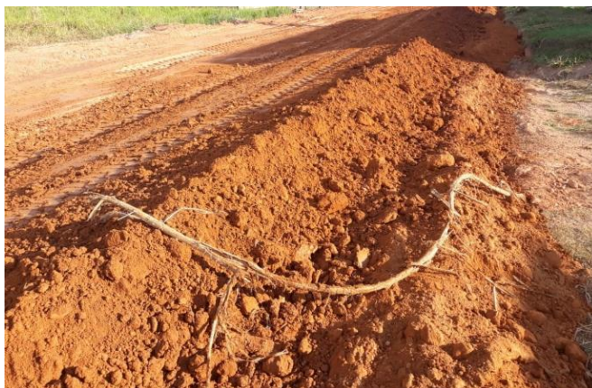
Figura 2.31 Distribución del material laterítico
