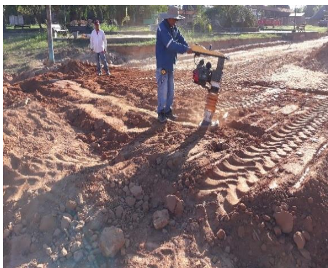
Figura 2.49 Relleno y compactado manual
