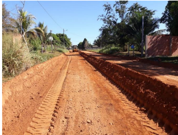
Figura 2.29 Corte con motoniveladora
