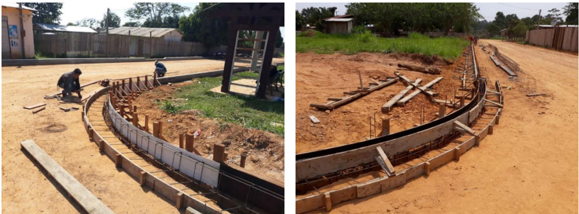
Figura 2.57 Encofrado de cordón cuneta en curva
