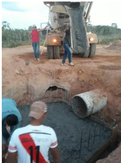
Figura 2.52 Hormigonado de las obras de arte
