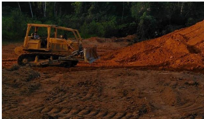
Figura 2.15 Tractor sobre orugas Bulldozer
