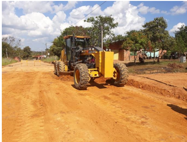
Figura 2.36 Nivelación de la capa base
