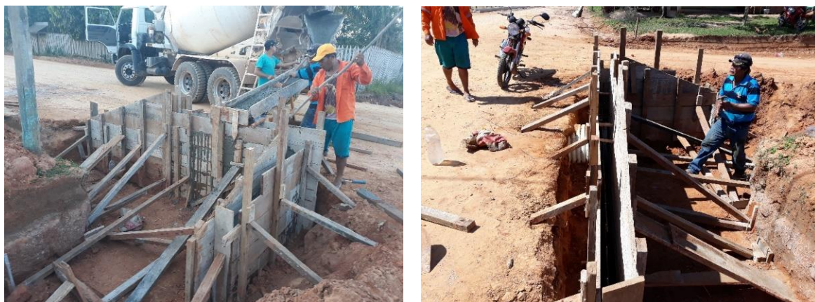
Figura 2.51 Encofrado de obras de arte
