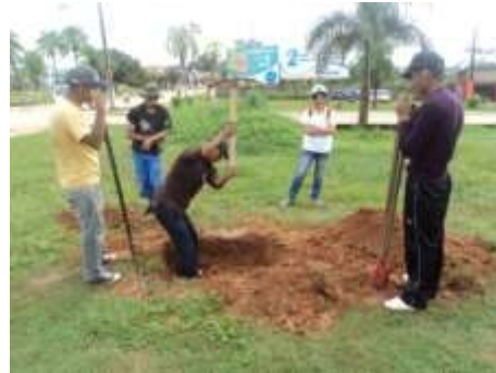
Figura. F.2. Ejecución calicata de 1.50m Fuente: Propia
