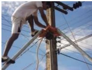
Figura. F.3. Equipo SPT Fuente: Propia
