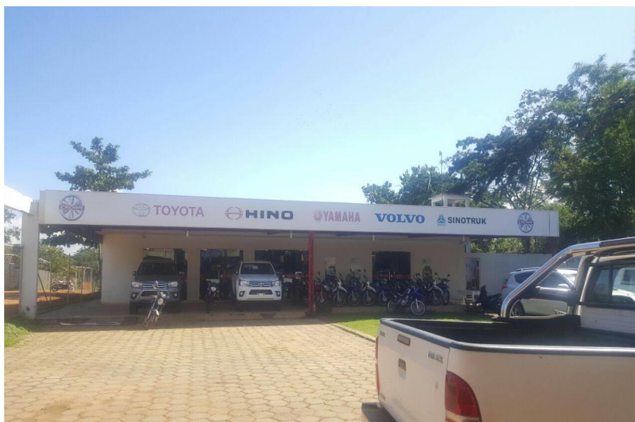
Figura 1 Frontis de los ambientes de Crown Ltda.
