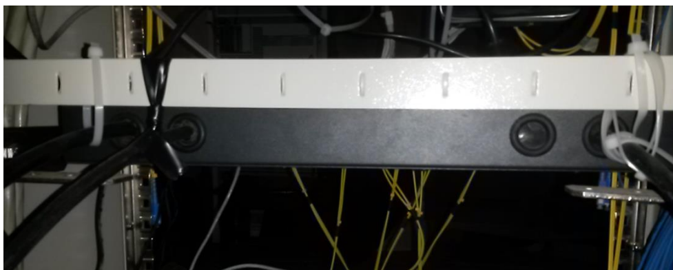
Ilustración 22 Ingreso al ODF (para la fusión de fibras)
