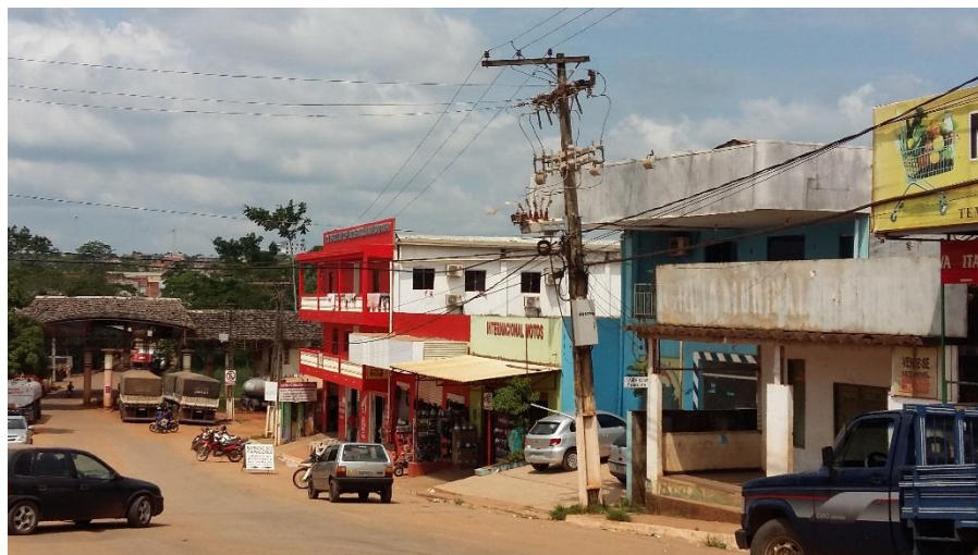
Ilustración 17 Tendido de F.O aéreo – Elaboración propia
