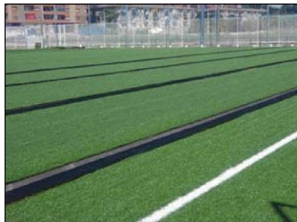
FIGURA 75. Tendido de rollos de césped sintético
