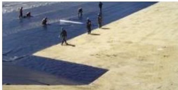
FIGURA 73. Impermeabilización de polietileno 120 micrones del terreno para cancha sintética.
