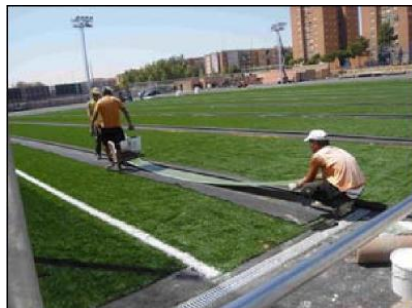
FIGURA 76. Unión de rollos de césped sintético
