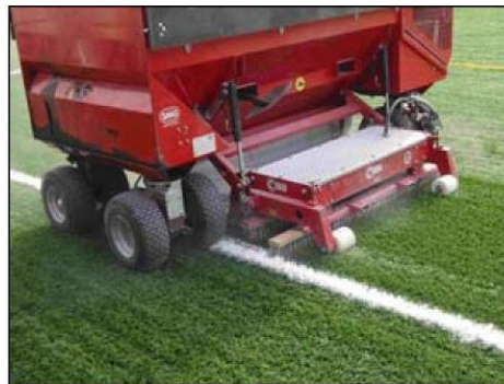
FIGURA 78. Riego de arena y caucho
