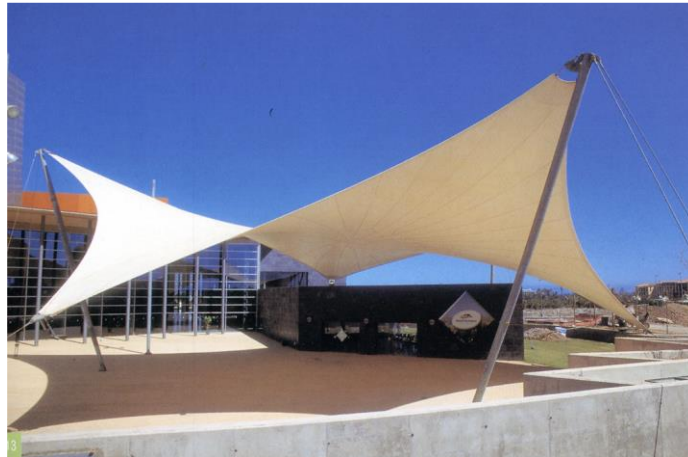
FIGURA 11. Diseño estructuras tensadas.
