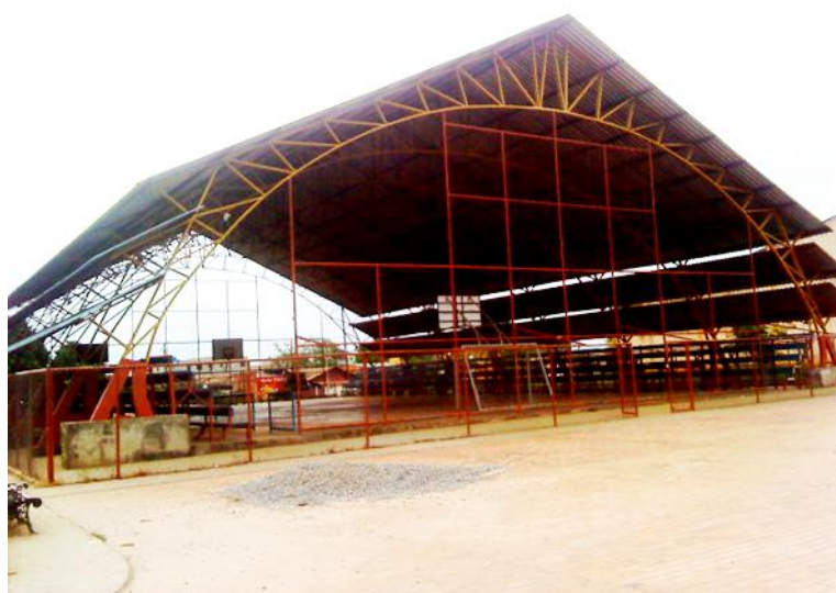
FIGURA 2. Coliseo abierto polifuncional, Parque Piñata.
