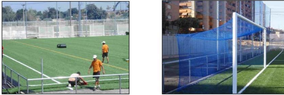
FIGURA 77. Colocación de líneas y colocación de arcos
