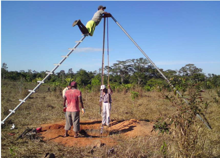
FIGURA 16. Sondeos de exploración. Ensayo de penetración estándar.
