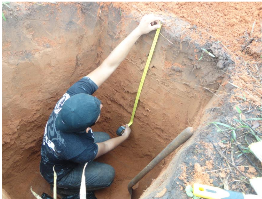
FIGURA 12. Prospección del sub-suelo. Calicata.
