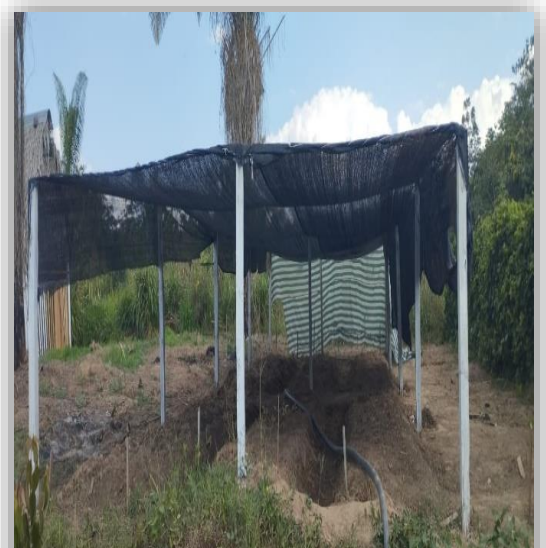
Culminacion y colocacion de la semi sombra temporal
