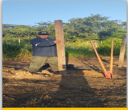
Avance de la preparacion
