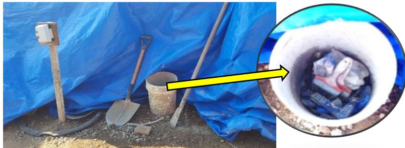
Figura 30. Antes de la implementación del orden y limpieza en el área de producción.
