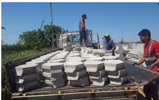
Figura 26. Transporte de losetas.
