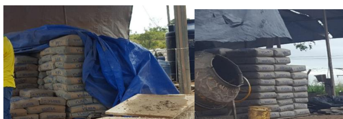
Figura 34. Antes de la implementación del orden y limpieza en almacén de cemento.
