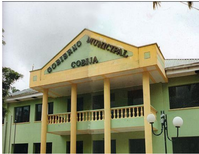
FIGURA 1 Edificio del Gobierno Autónomo Municipal de Cobija
