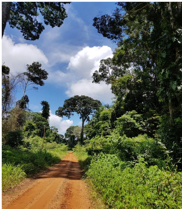
Figura 59. Vía a acceso a la TCO Yaminagua Machineri Fuente: Elaboración propia
