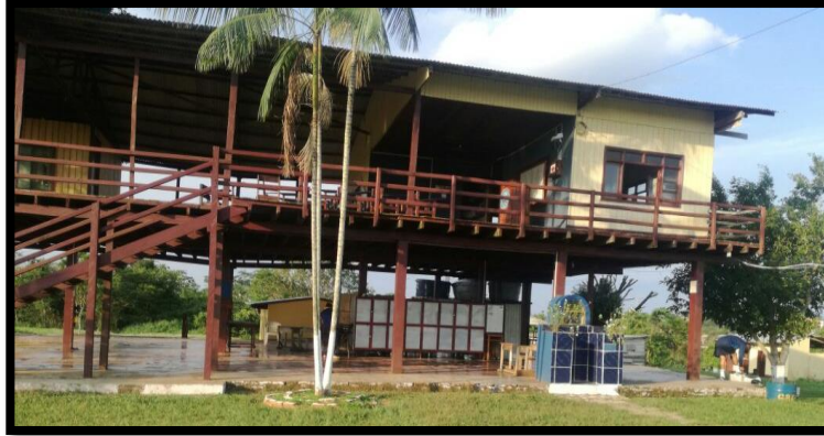
IMAGEN 1.3: Oficinas administrativas del Grupo Aéreo “64” FUENTE: Propia
