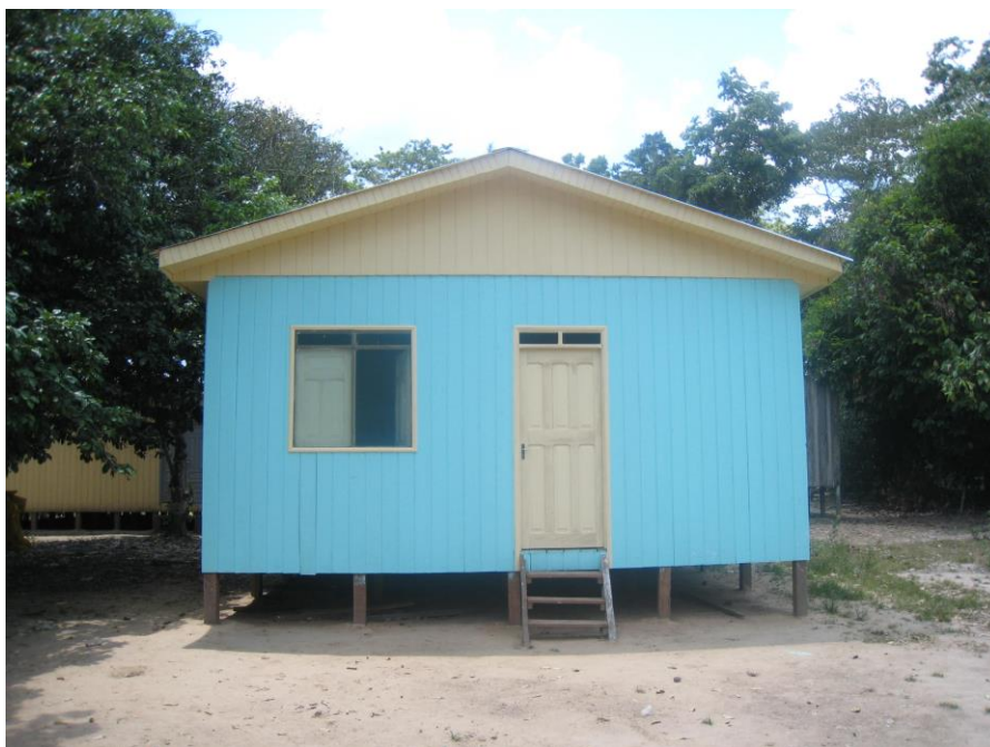
Vivienda nueva construida por la Alcaldía de Bella Flor
