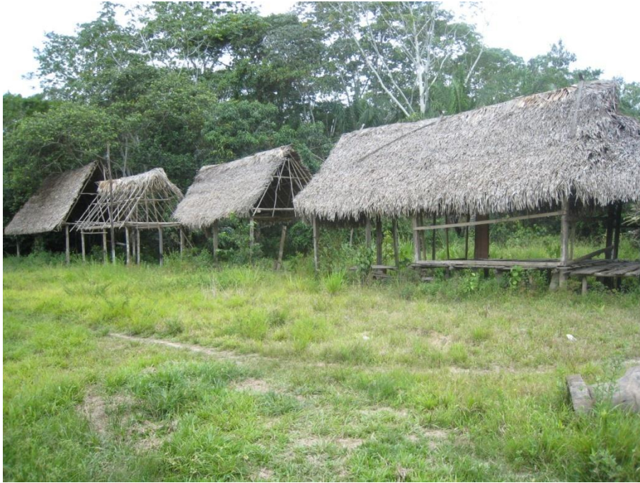
Las viviendas antiguas de Florida, vulnerables a las inundaciones
