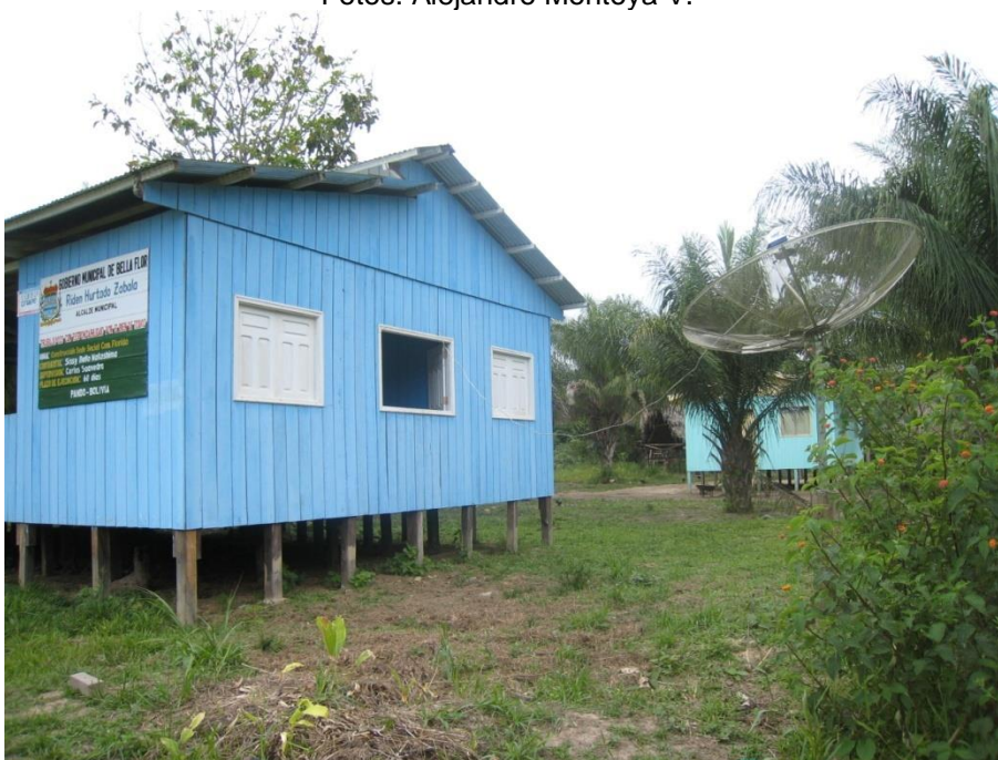
En la sede social de la comunidad está instalada la antena parabólica que no funciona Fotos: Alejandro Montoya V.
