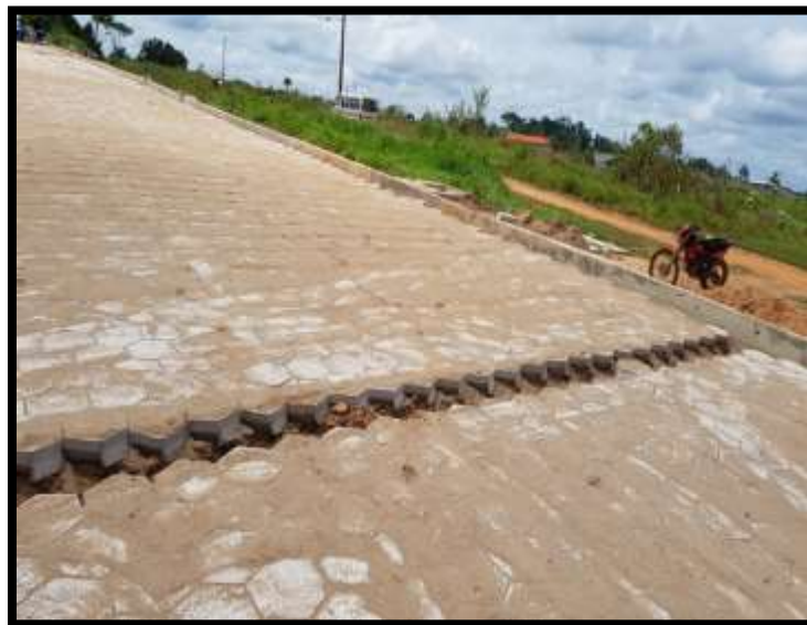
Figura 33. Excavación manual para vigas de confinamiento Fuente: Elaboración propia
