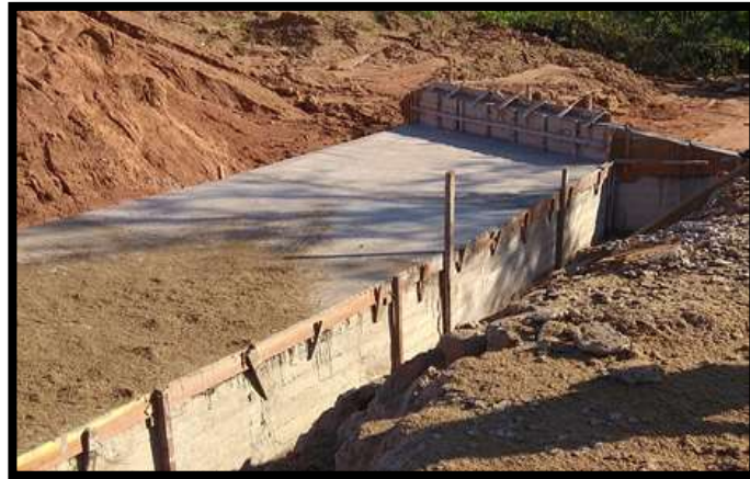
Figura 29. Desencofrado Fuente: Elaboración propia
