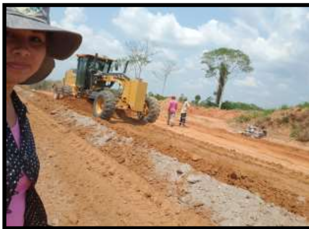
Figura 13. Materiales para capa base Fuente: Elaboración propia
