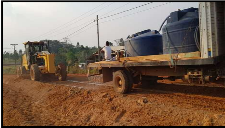
Figura 14. Conformado de la capa base (suelo cemento) Fuente: Elaboración propia
