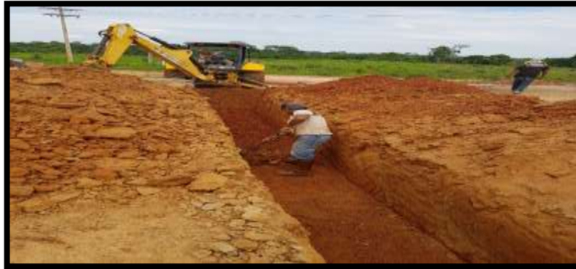
Figura 20. Excavación con maquinaria. Fuente: Elaboración Propia.
