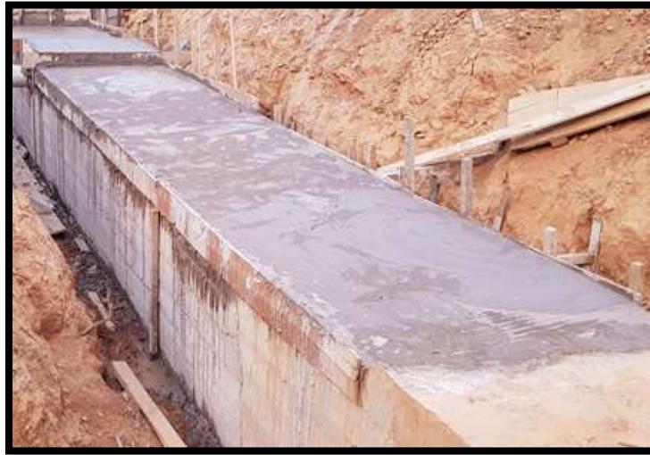
Figura 31. Desencofrado de alcantarilla simple Fuente: Elaboración propia
