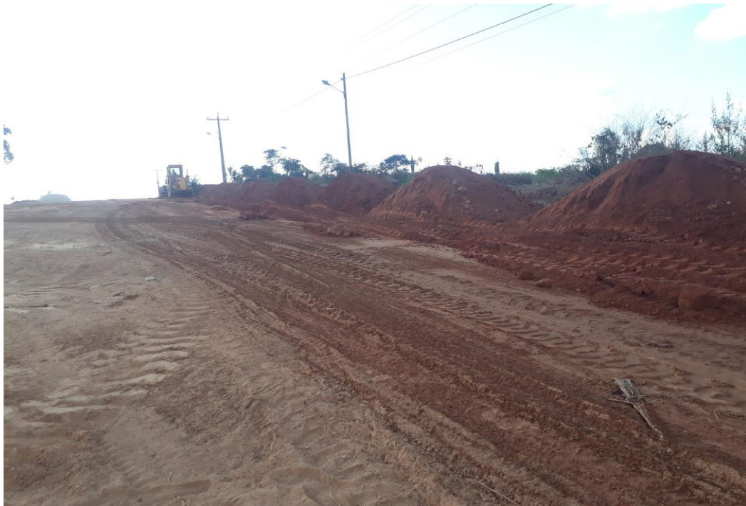
Tendido de material progresiva 1+750 - 1+960
