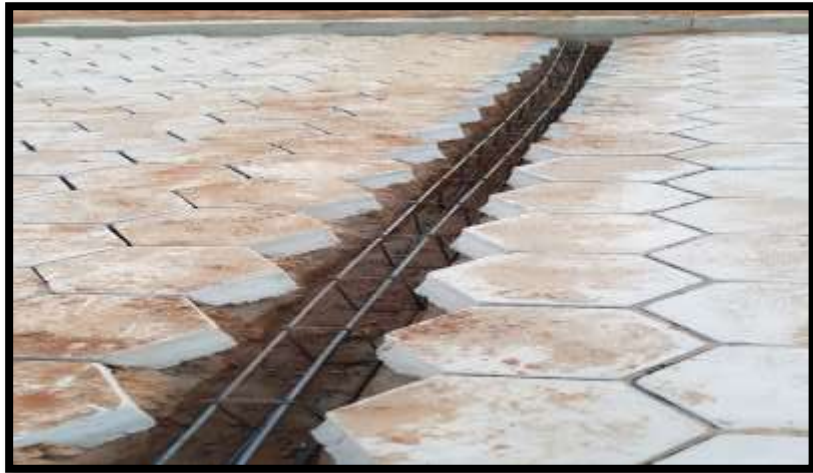
Figura 37 Armado vigas de confinamiento. Fuente: Elaboración propia
