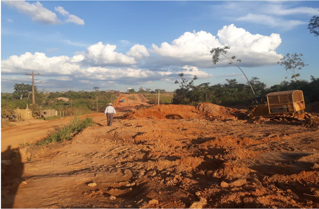
Acopio de material para relleno
