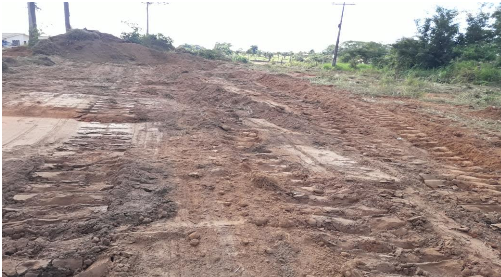
Limpieza de la plataforma Progresiva 1+750
