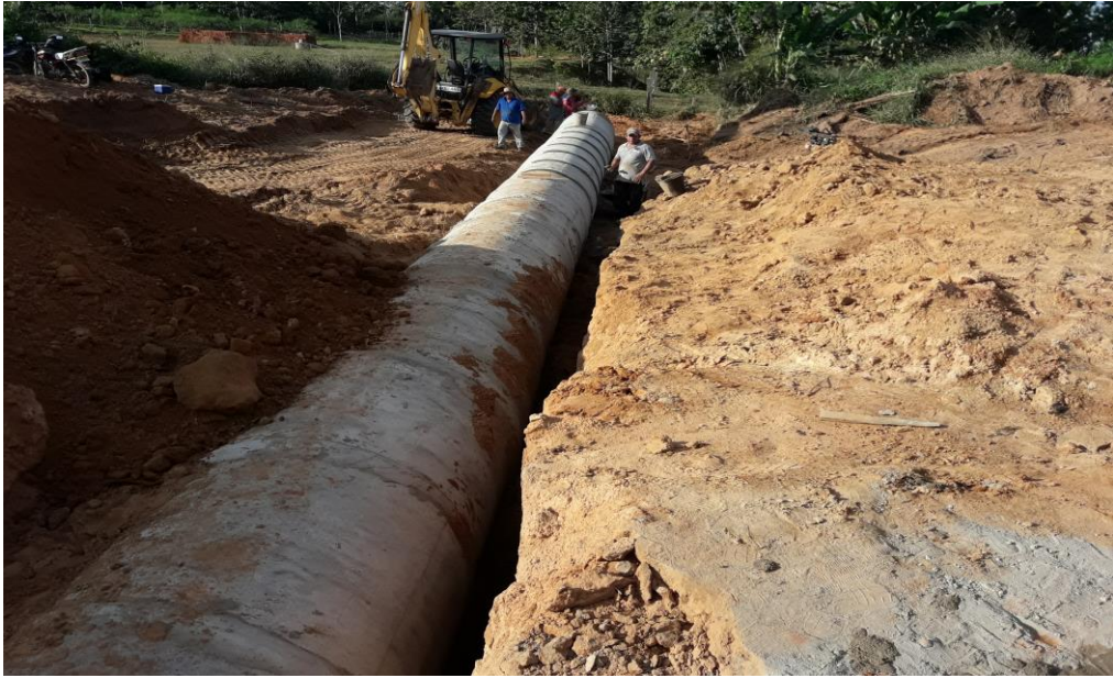
Colocado de tubo de H A Progresiva 2+000
