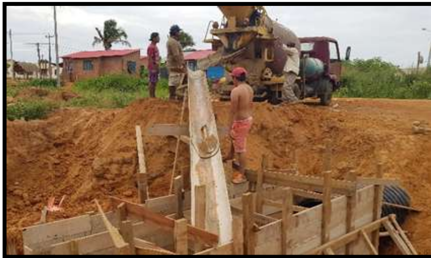
Figura 18. Camión Mixer Fuente: Elaboración Propia
