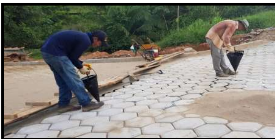
Figura 47. Sellado de junta con cemento asfáltico Fuente: Elaboración propia
