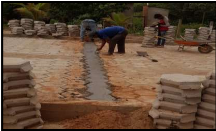
Figura 38. Vaciado de vigas de confinamiento Fuente: Elaboración Propias
