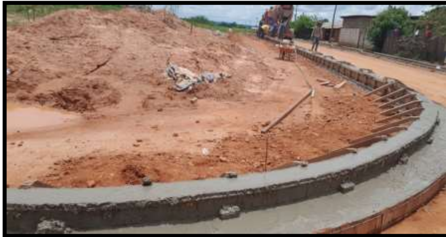
Figura 36. Vaciado cordón cuneta Fuente: Elaboración propia
