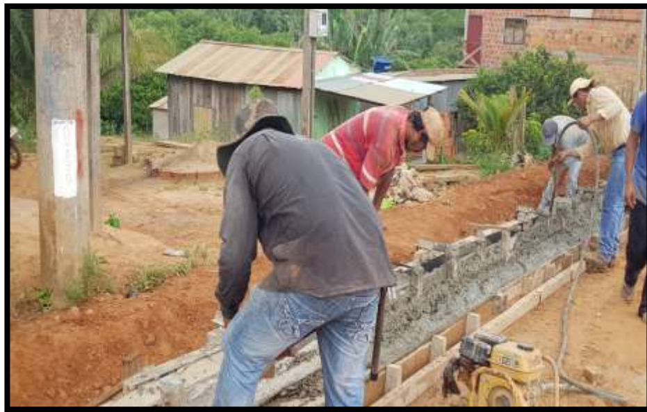
Figura 34. Vaciado de hormigón para cordones Fuente: Elaboración propia
