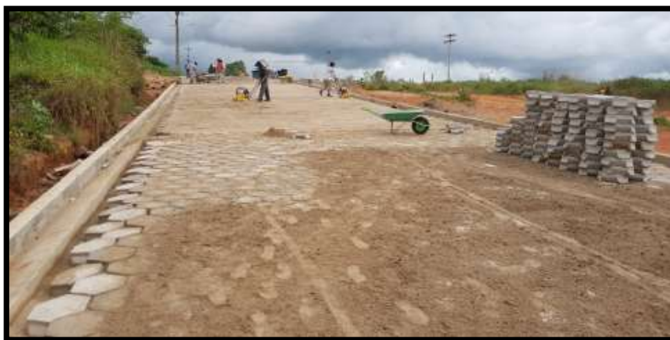
Figura 44. Superficie del enlosetado Fuente: Elaboración Propia
