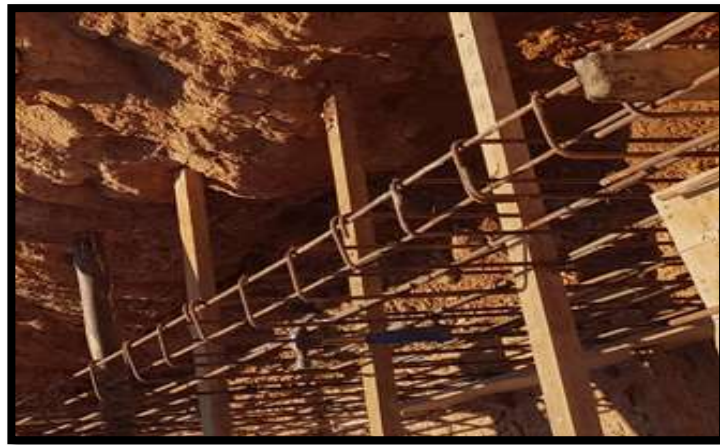
Figura 24. Armado de obras de drenaje (Alcantarilla). Fuente: Elaboración Propia.
