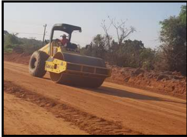
Figura 15. Compactado de la capa base (suelo cemento). Fuente: Elaboración Propia
