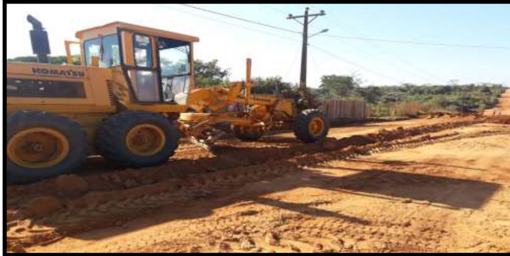
Figura 10. Corte y Relleno Fuente: Elaboración propia
