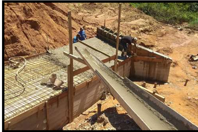
Figura 27. Vaciado de hormigón armado para alcantarilla doble cajón Fuente: Elaboración propia
