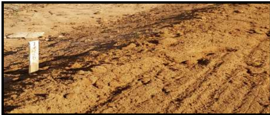
Figura 11: Estaqueado Figura: Elaboración propia
