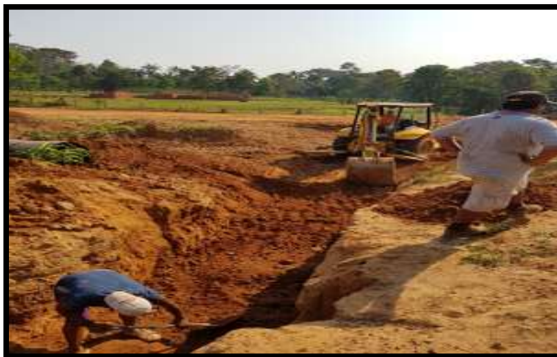
Figura 19. Excavación con maquinaria Fuente: Elaboración Propia
