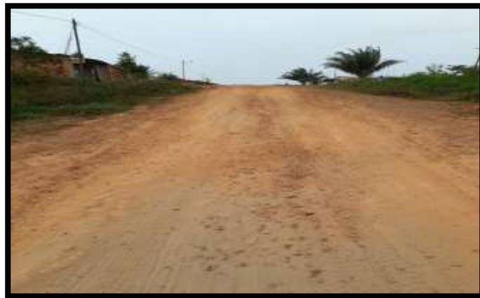
Figura 4 Canal de erosionado por las lluvias Fuente: Elaboración Propia
