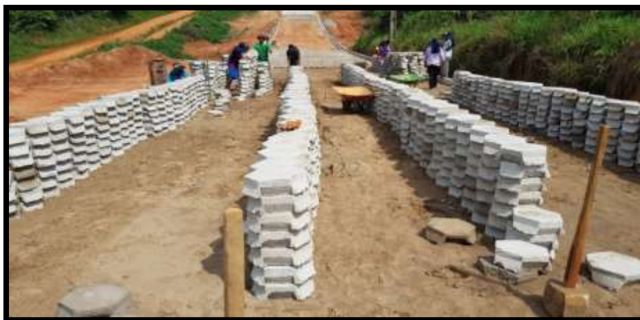
Figura 42. Acopio de losetas para su colocado Fuente: Elaboración propia
