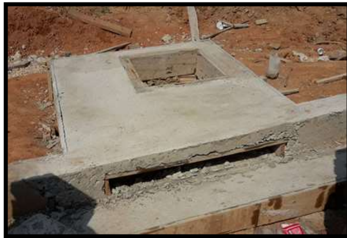
Figura 30. Desencofrado de cámara Fuente: Elaboración propia
