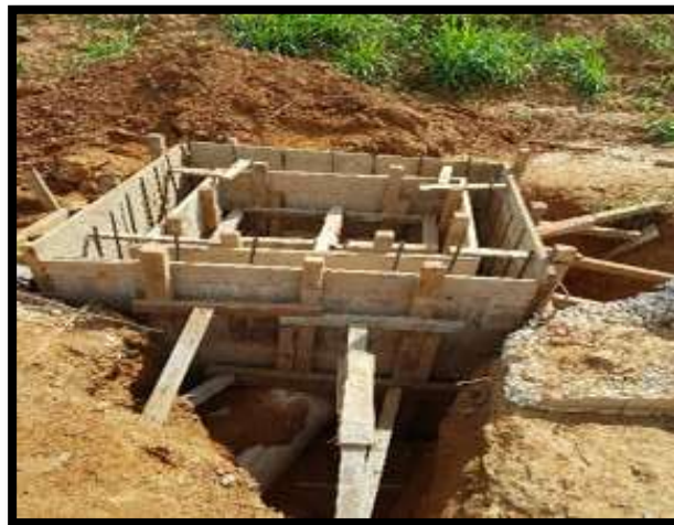
Figura 26. Encofrado y apuntalado para cámaras de inspección Fuente: Elaboración propia
