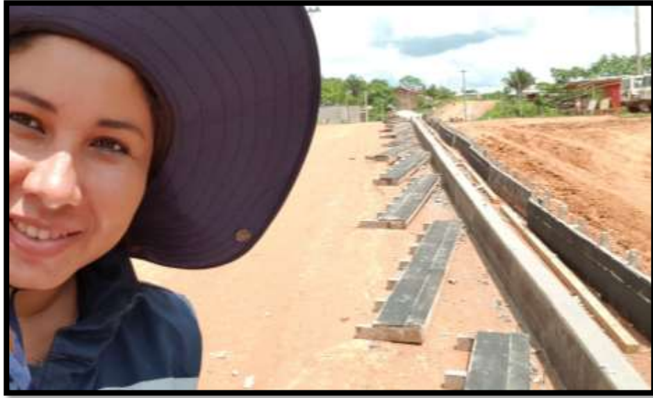
Figura 35. Desencofrado de cordón Fuente: Elaboración propia
