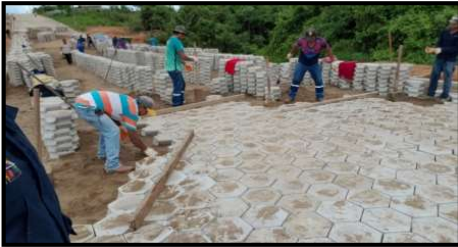
Figura 43. Colocado de losetas Fuente: Elaboración propia
