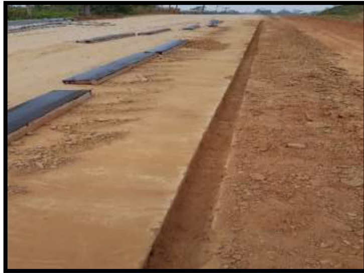
Figura 1. Excavación manual para cordones Fuente: elaboración propia
