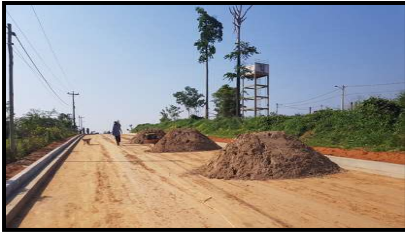
Figura 41. Superficie de la capa base compactada y limpia Fuente: Elaboración Propia
