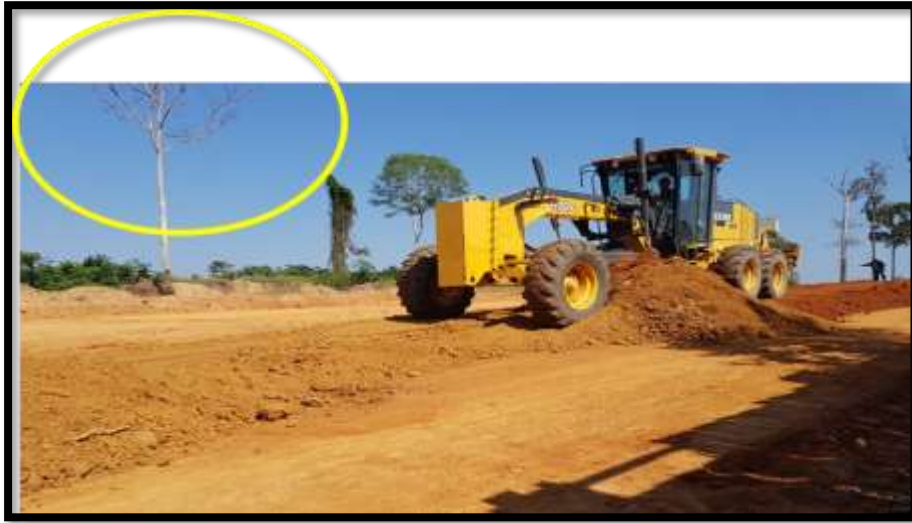
Figura 12. Conformado de capa sub base Fuente: Elaboración propia
