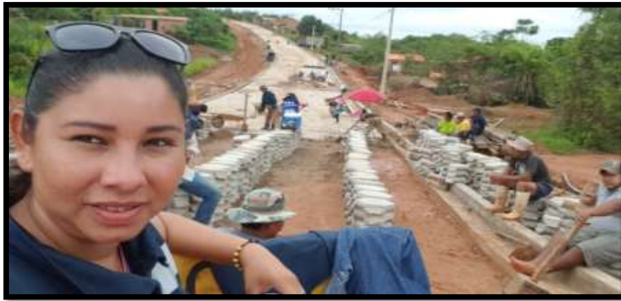
Figura 76. Personal de Enlosetado Fuente: Elaboración propia
