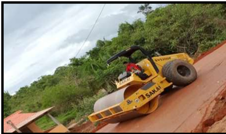
Figura 23. Compactado con rodillo liso Fuente: Elaboración propia
