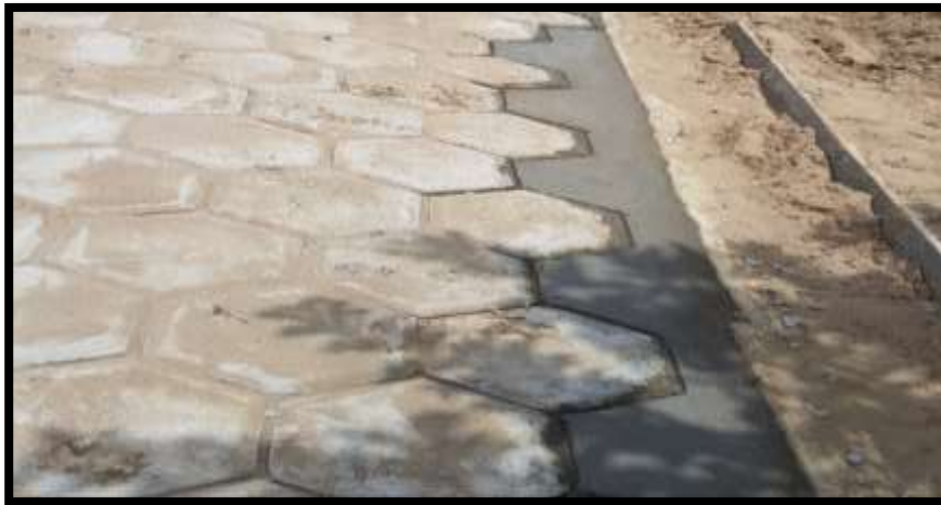
Figura 45. Remates de hormigón simple Fuente: Elaboración propia
