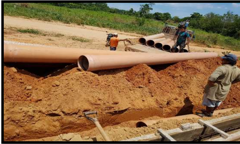
Figura 22. Relleno y compactado manual P/alcantarilla y tuberías de PVC Figura: Elaboración Propia
