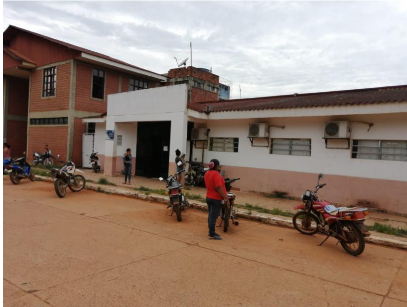
Anexo 1: Centro de Salud Puerto Rico Fuente elaboración propia
