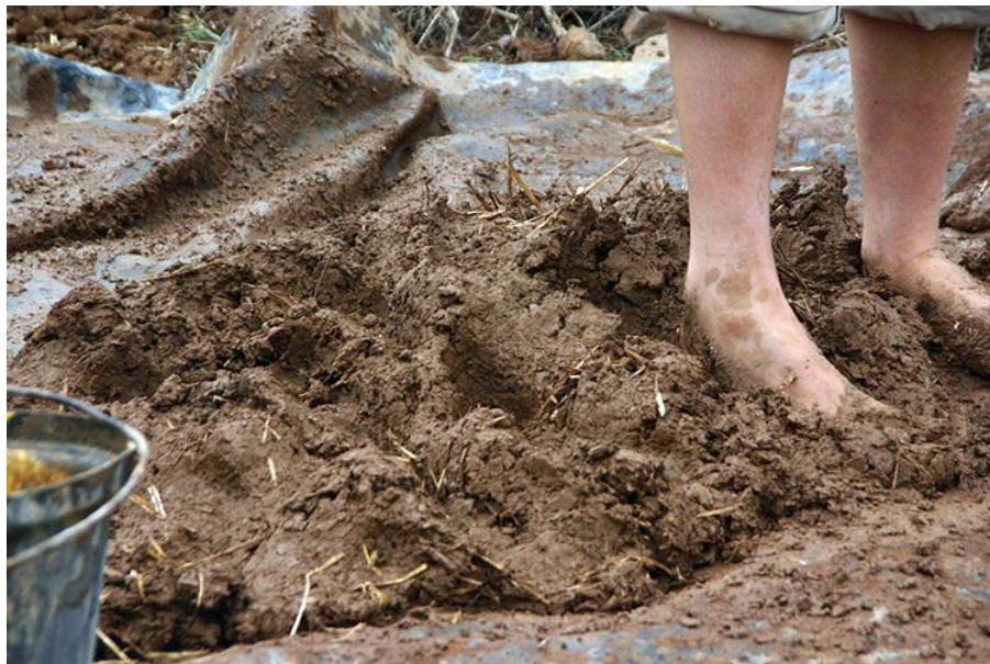
Mezclado de la arcilla con los aditivos homogéneamente para fermentación
