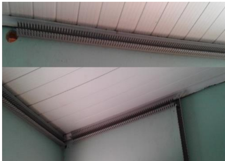
Figura 3.29 Reparación las vías del cableado mediante canaleta ranuradas Fuente: Elaboración propia
